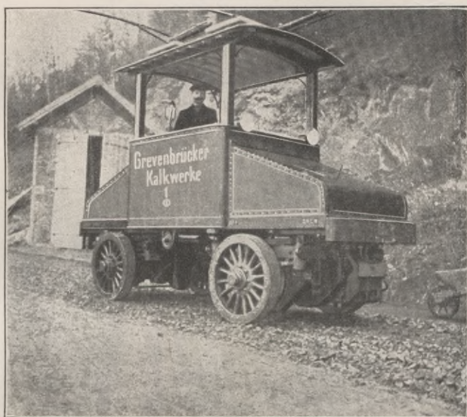
Abwalzen der Schotterbahn durch den Zugwagen selbst.
