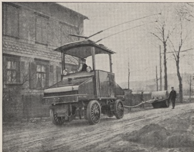
Abwalzen der Schotterbahn durch angehängte Walze.
