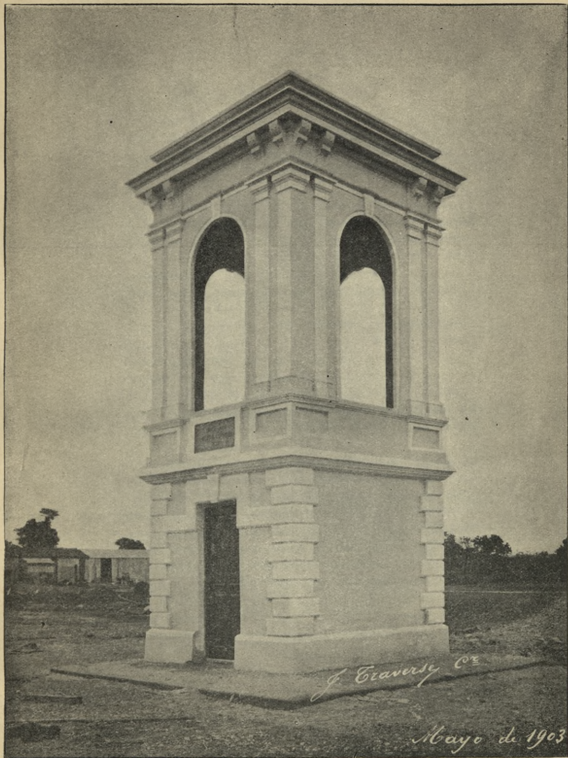
Núm. 16 — Casilla de maniobras
