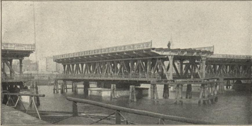
Abb. 8. Ausgeschwenkte Drehbrücke.
