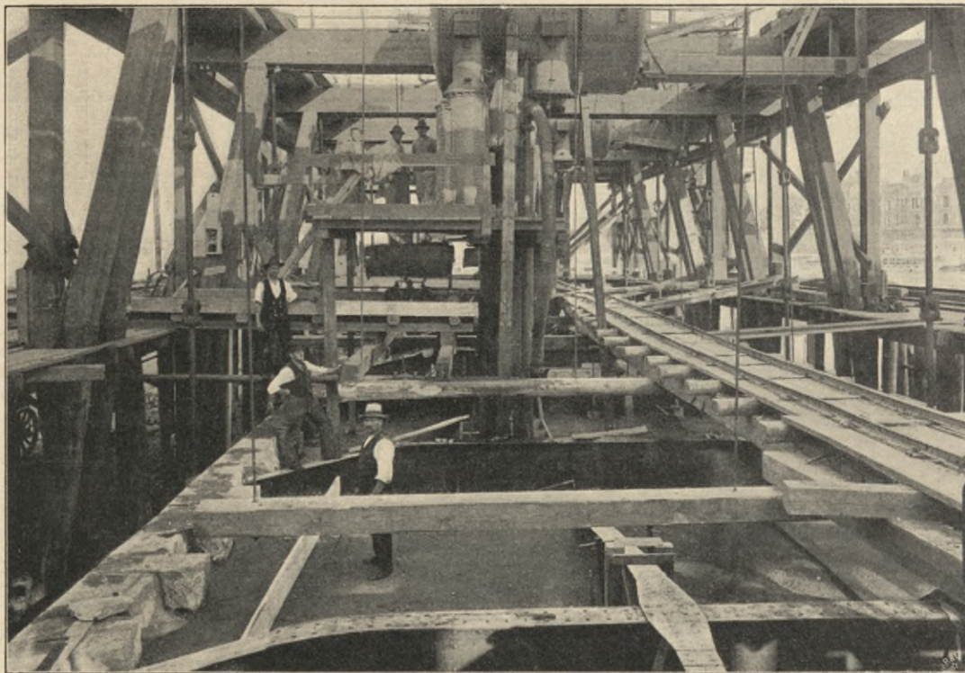
Abbildung 14. Aufmauerung der I. Schicht auf Pfeiler V nach Versenkung des Kaiisons (19. 8. 08).
