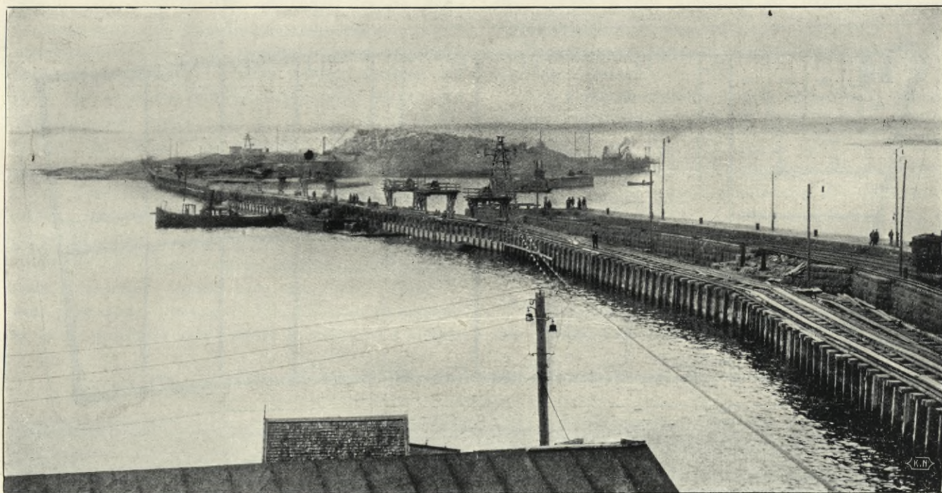
Môle de Hangö. Etat des travaux en 1905.
