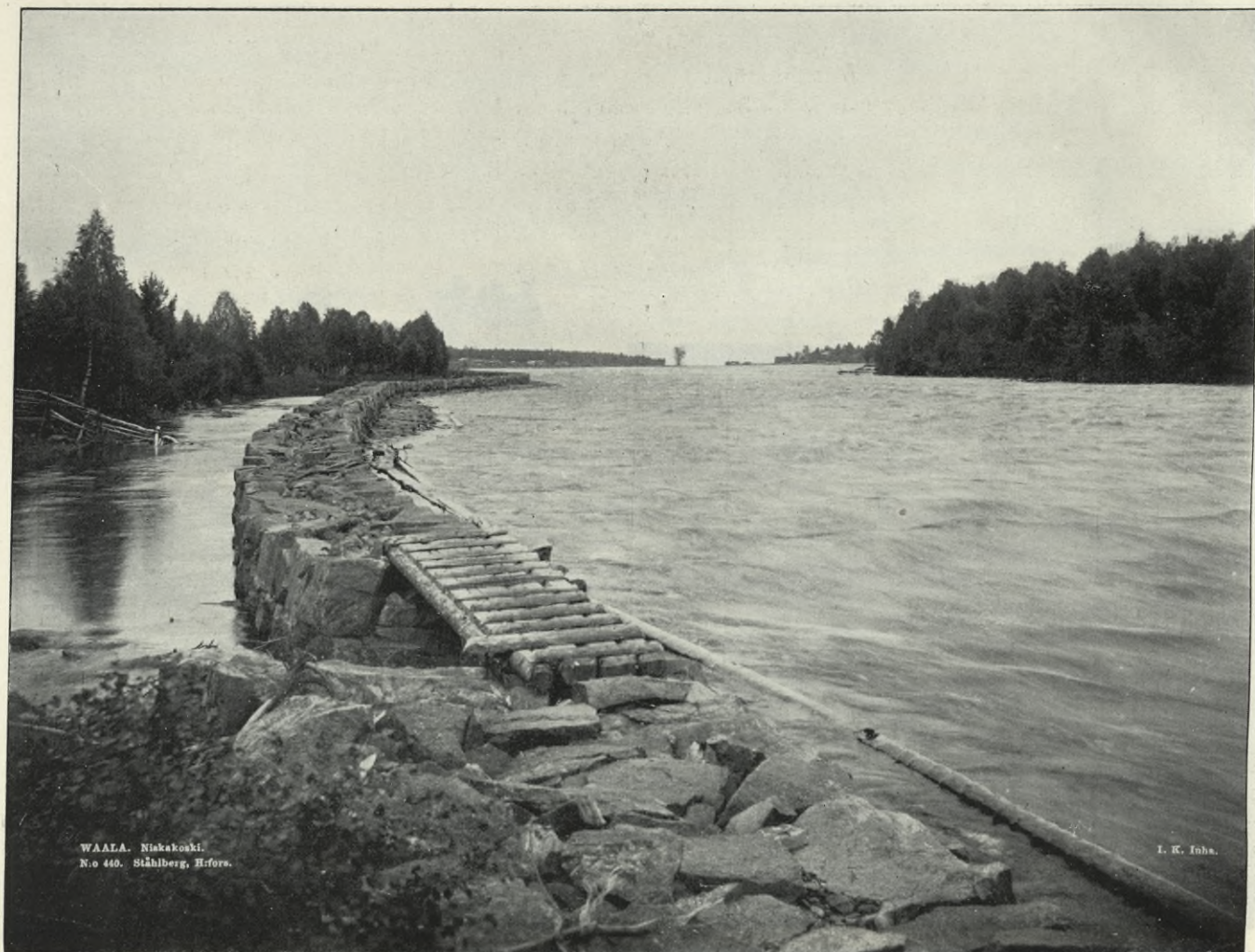
DIGUE DE HALAGE.
