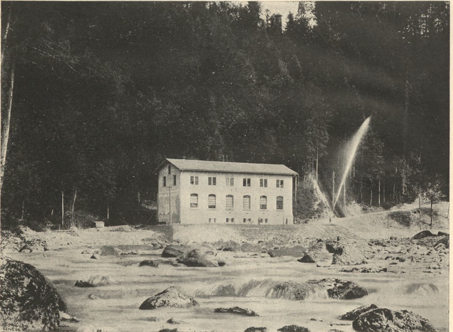
Fig. 31. Ansicht des Maschinenhauses (Auf der Höhe: der Luftschaft der Rohrleitung).
