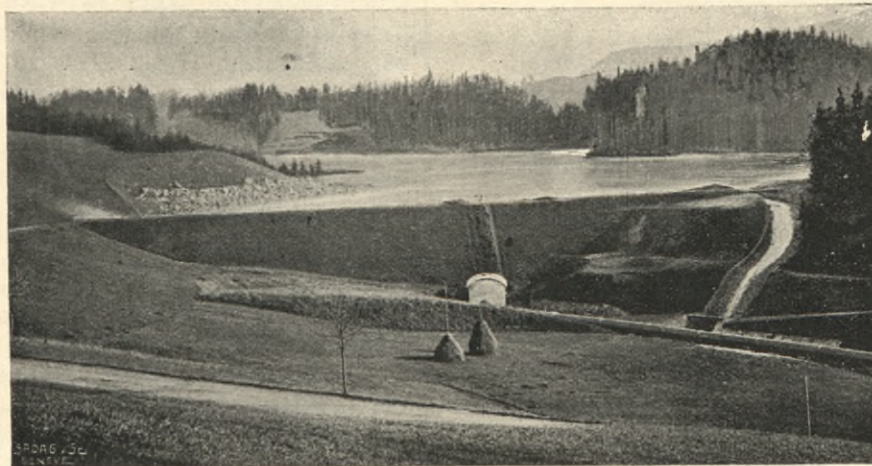
Fig. 21. Ansicht von Weier und Damm mit Ueberlauf und Rohrleitung.
