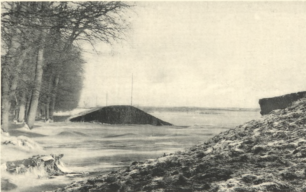
Abbildung 12: Deichbruch bei Dom. Mühlenholz.
