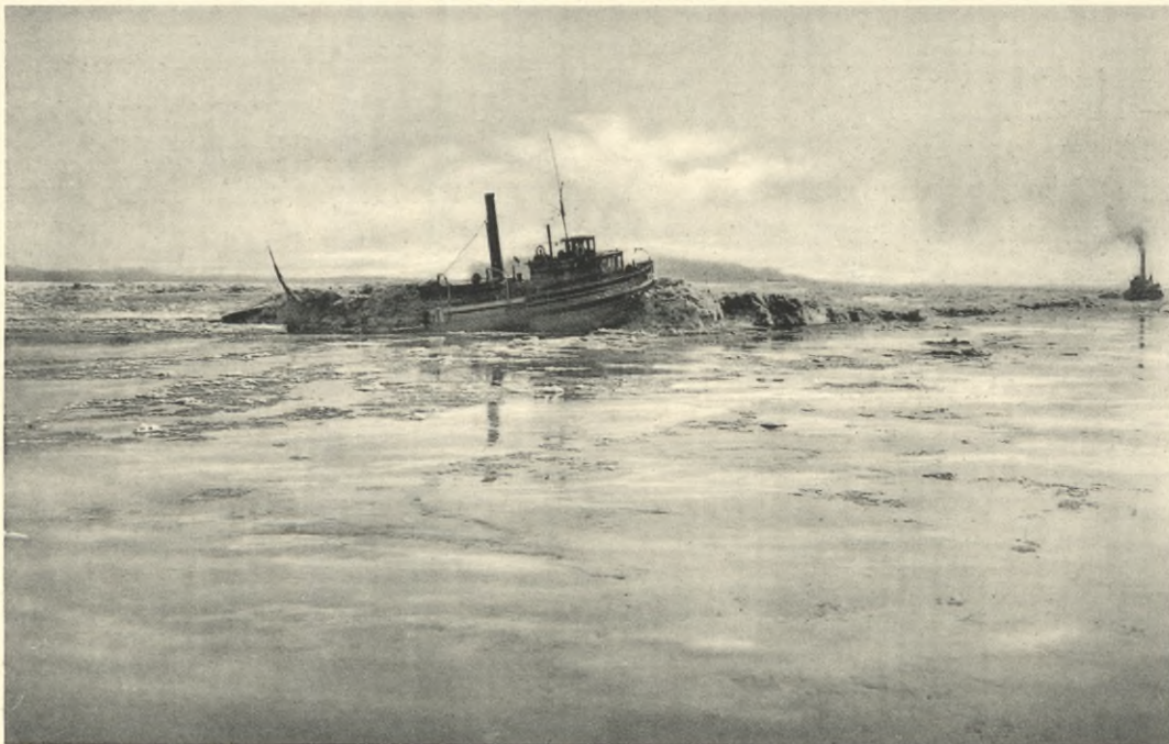
Abbildung 5: Rammartiges Arbeiten eines Eisbrechers.
