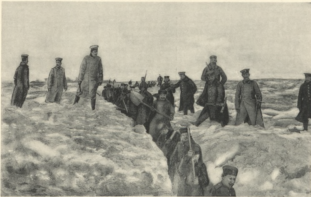
Abbildung 16: Herstellung der Längsgräben.
