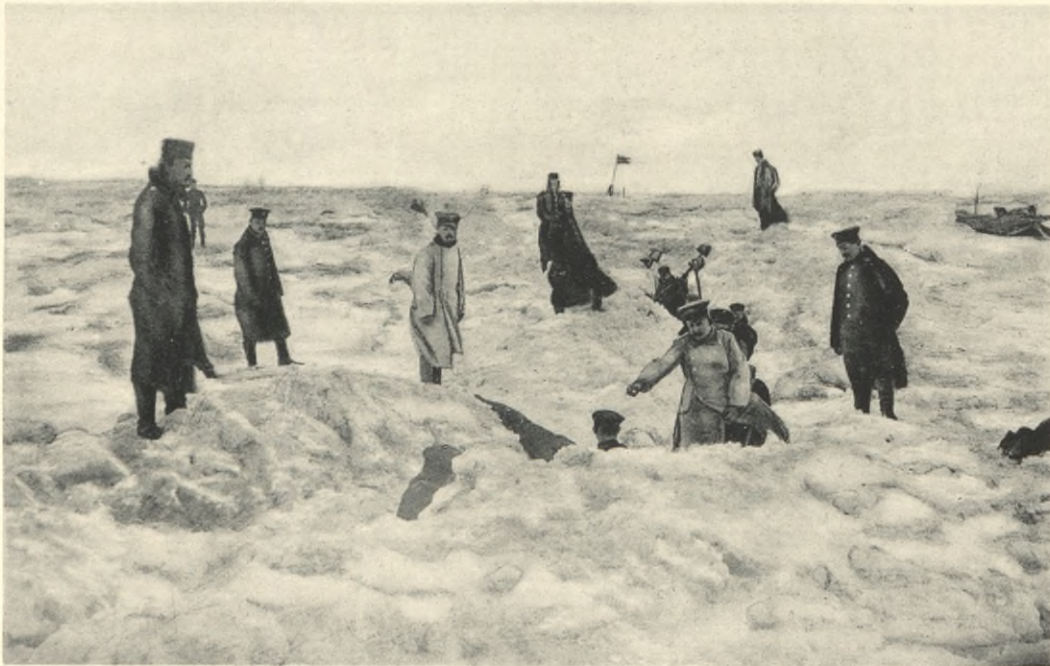
Abbildung 17: Herstellung der Längsgräben.
