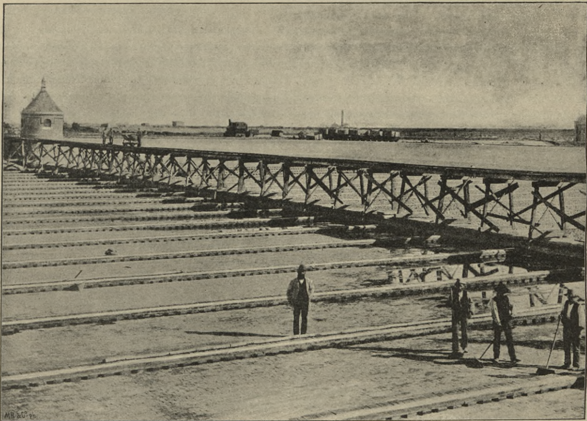
Fig. 15. Beschickung eines Filters-Bassins mit Steinen.
