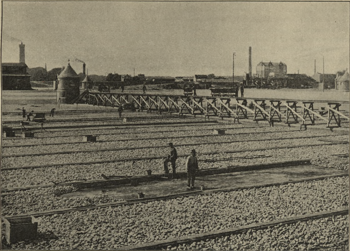
Fig. 16. Beschickung eines Filter-Bassins mit Kies.
