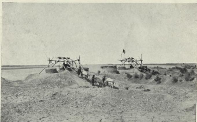
Abb. 11. Wasserhebevorrichtungen (Tscherds) am Euphrat.
