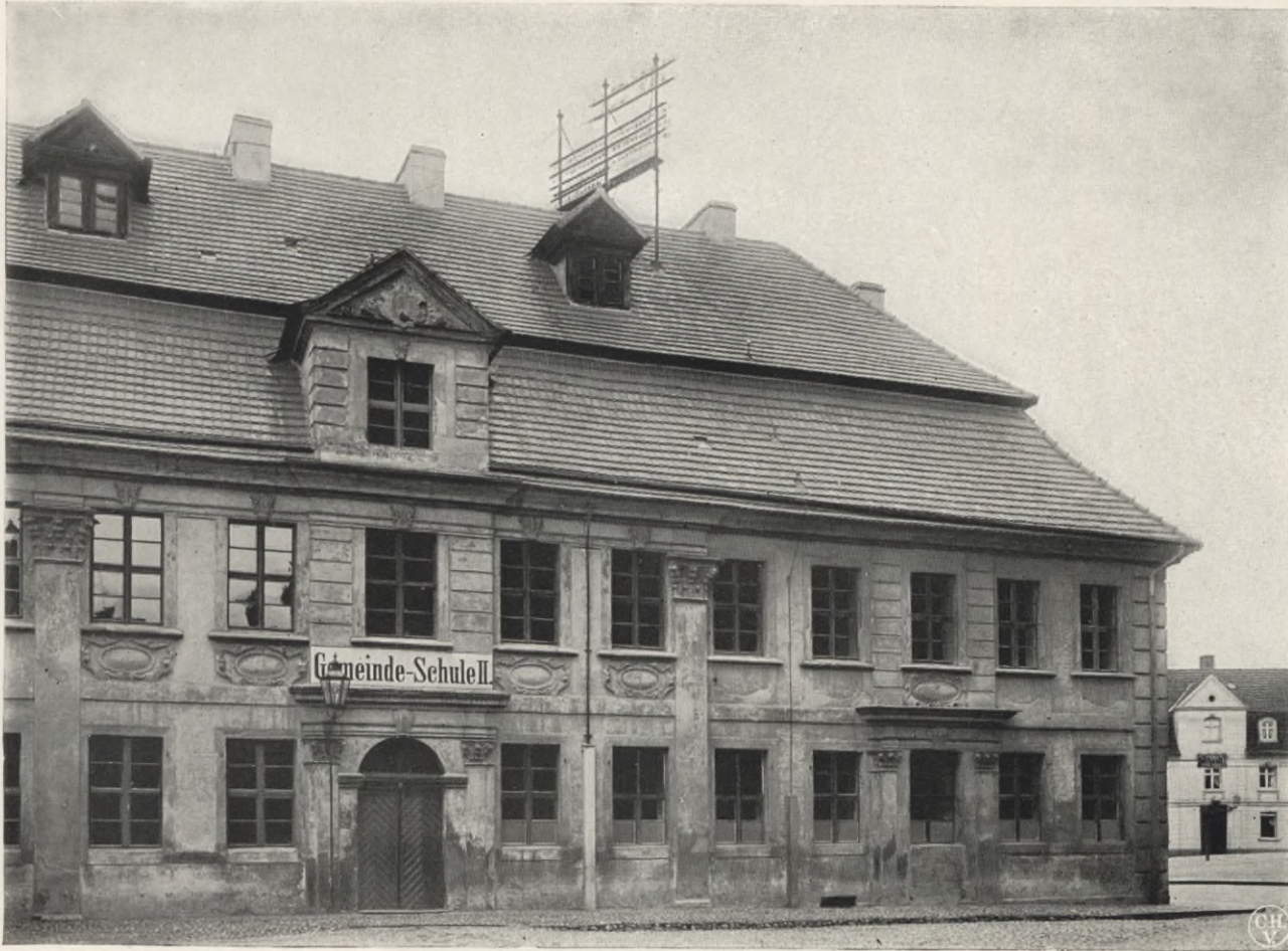
Abb. 21. Ehemaliges Gymnasium in Cottbus (vgl. Abb. 19 und 23)
