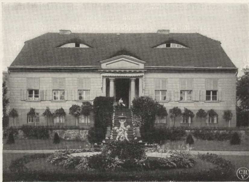
Abb. 1. Haus in Kottbus von 1828. Gartenansicht
