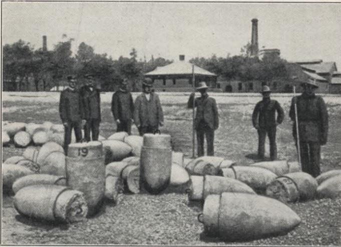
Abb. 42. Pfahlschuh aus mit Streckmetall armiertem Beton.
