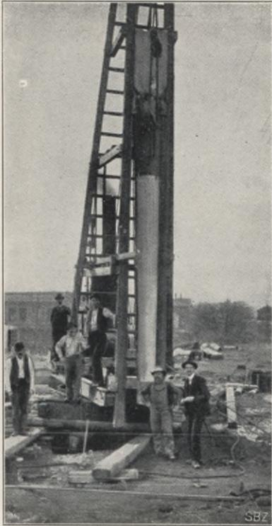
Abb. 37. Rammkern in die Stahlhülse eingeführt.
