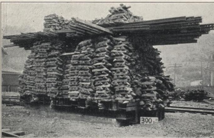
Abb. 50. Probelastung von «Simplex-Pfählen».
