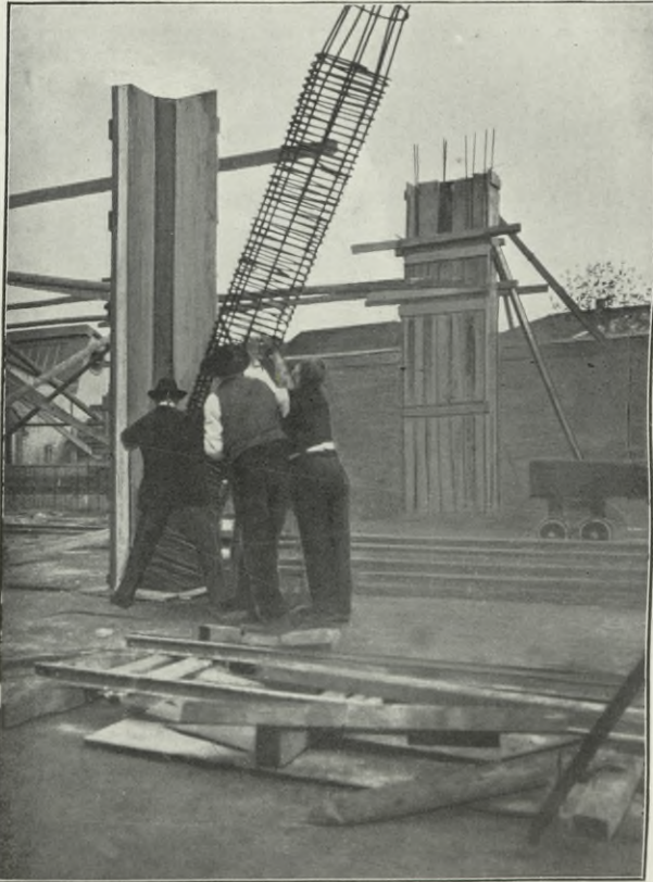
Fig. 14. Einbringen einer Spiralarmierung in die Schalung für eine Säule.
