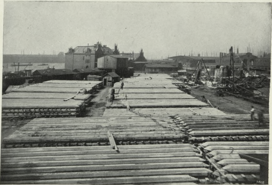
Fig. 35. Lager spiralumschnürter Eisenbetonpfähle für das Gaswerk Grasbrook bei Hamburg.
