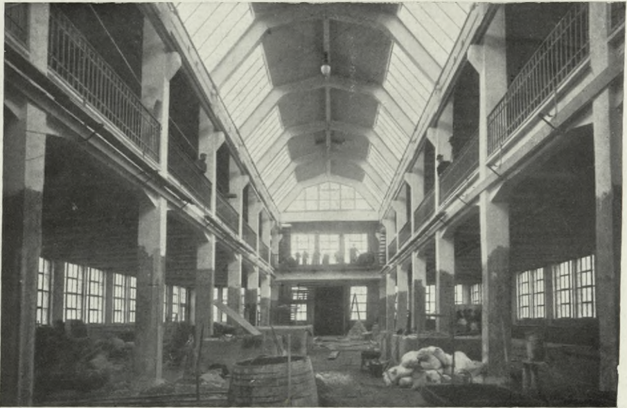
Fig. 24. Innenansicht des Neubaues für die Firma Bosch-Feuerbach . Montagenhalle mit stark belasteten spiralumschnürten Säulen.
