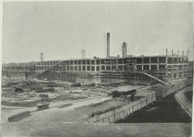
Fig. 25. Gesamtansicht des Neubaues der Firma Singer Manufacturing Co. in Wittenberge mit spiralumschnürten Säulen.
