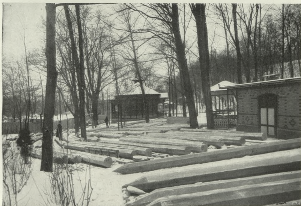
Fig. 34. Pfahlager spiralumschnürter Eisenbetonpfähle für die Kursaalfundamente in Kannstadt.
