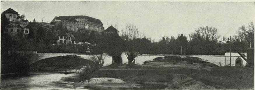
Fig. 46. Ansicht der Brücke Fig. 45 nach dem Ausschalen.
