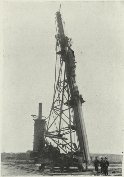
Fig. 38. Spiralumschnürter Pfahl schräg gerammt bei dem Baue der Fußgängerbrücke am neuen Ostbahnhof in Frankfurt a. M. Beginn des Rammens.
