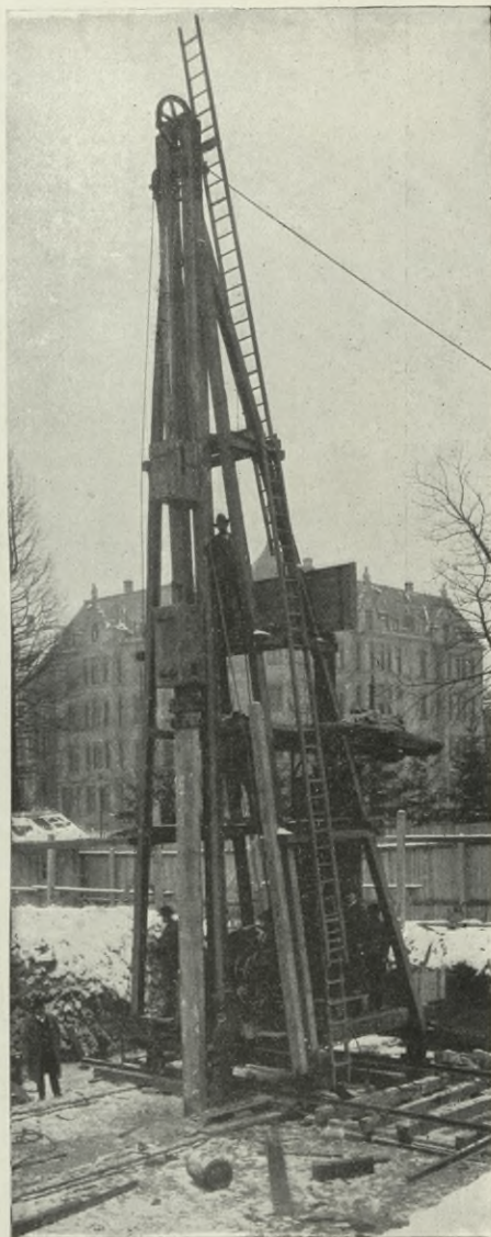
Fig. 37. Rammen eines spiralumschnürten Eisenbetonpfahles.
