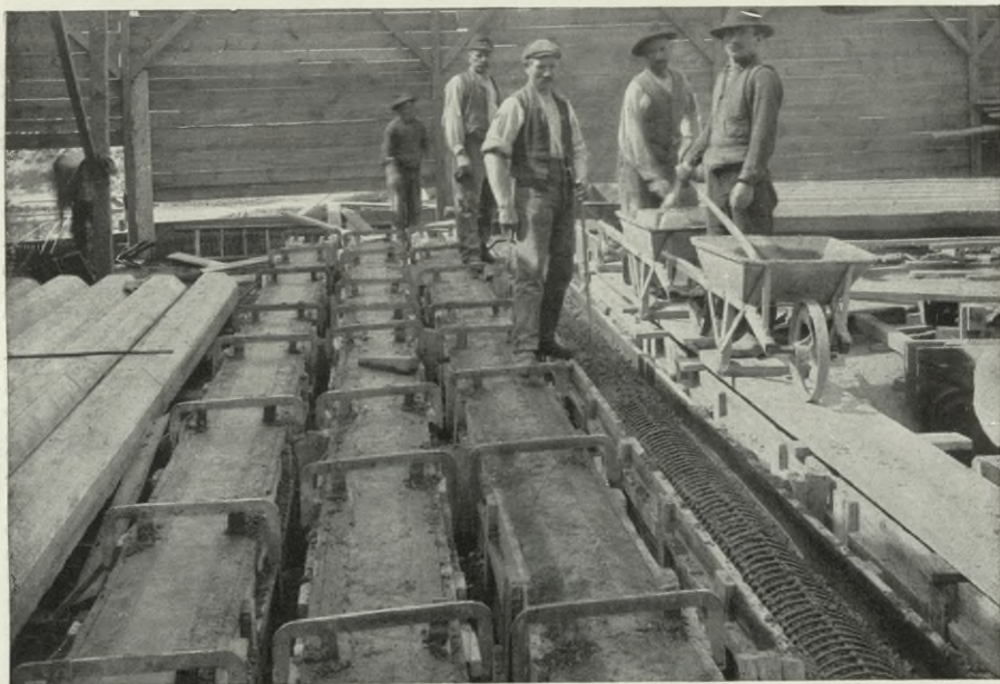
Fig. 33. Betonieren der spiralumschnürten Eisenbetonpfähle.
