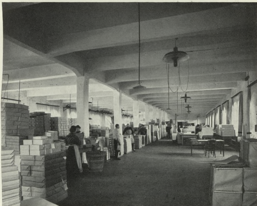
Fig. 13. Spiralarmierte Träger in der Papierfabrik Neuß.
