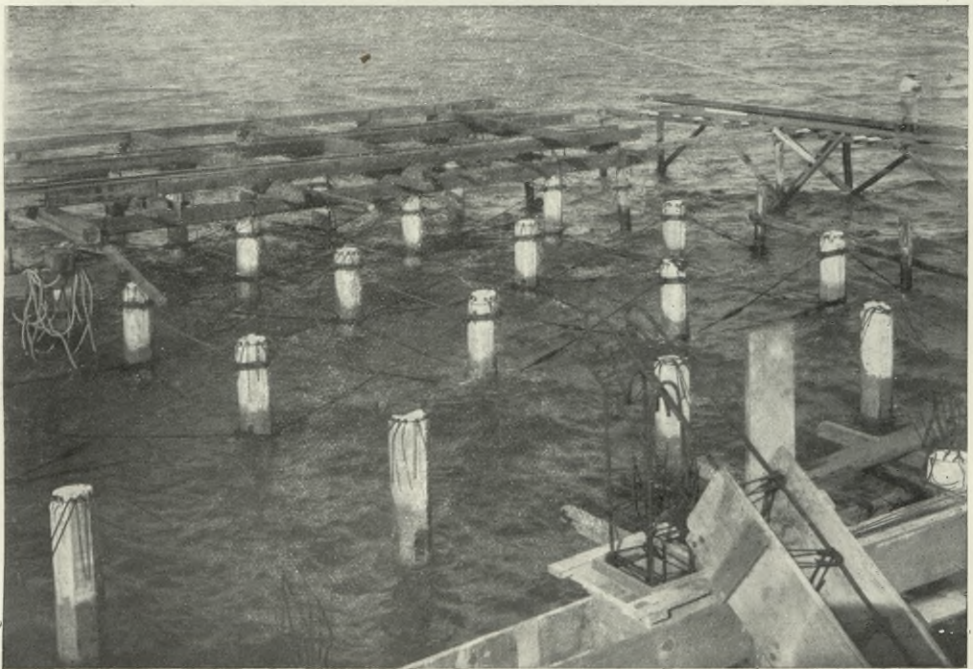
Fig. 43. Ohne elastische Zwischenlage gerammte spiralumschnürte Eisenbetonpfähle im Meere bei Bagnoli für die Anlage Fig. 42.
