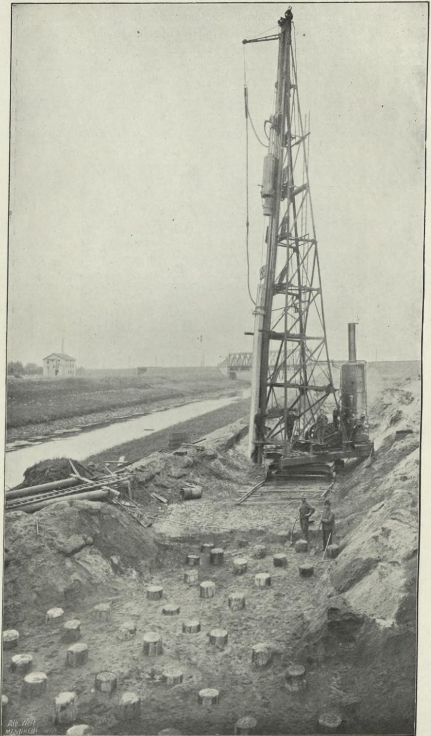
Fig. 41. Rammung spiralumschnürter Eisenbetonpfähle auf der Eisenbahnstrecke Oberhausen (Rheinland)-Wesel.
