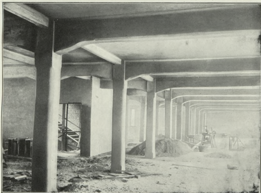
Fig. 20. Innenansicht des Untergeschosses im Neubau Schröder-Hamburg mit spiralumschnürten stark belasteten Tragsäulen.
