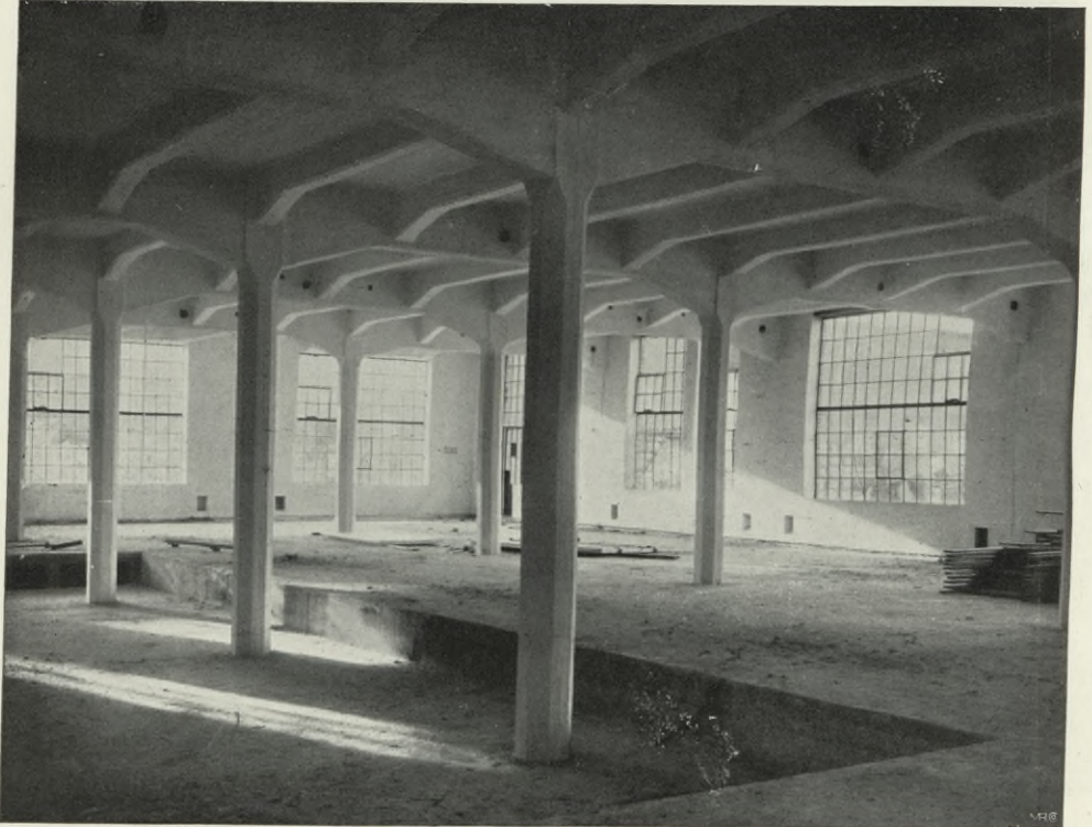
Fig. 21. Neubau Schröder-Hamburg . Innenansicht des Obergeschosses mit sehr schlanken spiralumschnürten Säulen.
