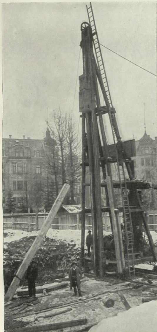
Fig. 36. Hochziehen eines spiralumschnürten Eisenbetonpfahles durch die Ramme.
