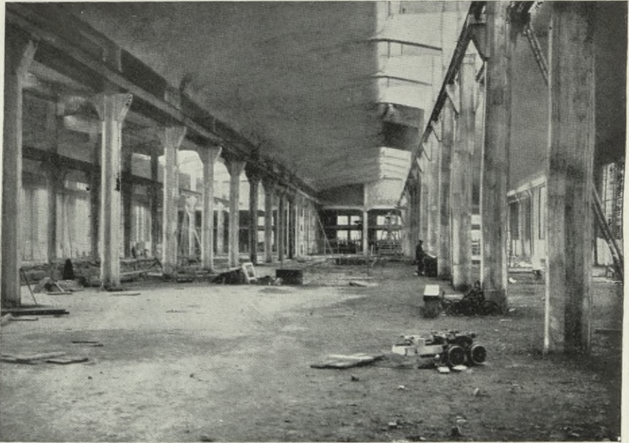
Fig. 18. Innenansicht des Neubaus für die „Papyrus“ A.-G. in Mannheim-Waldhof mit spiralumschnürten Säulen für hohe zentrische und exzentrische Lasten.
