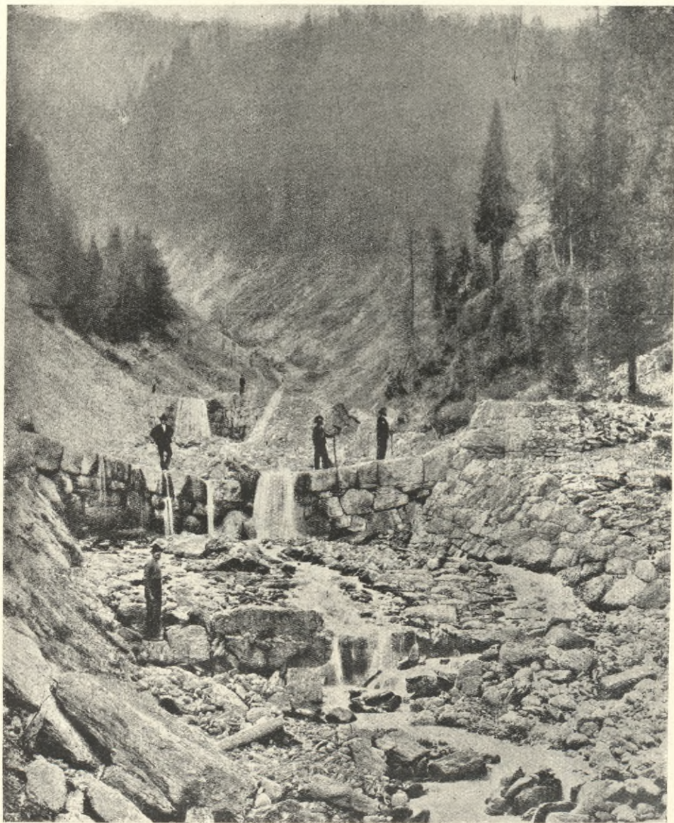
Thalsperrenbau im Niederurnerbach. Text rückseitig.
