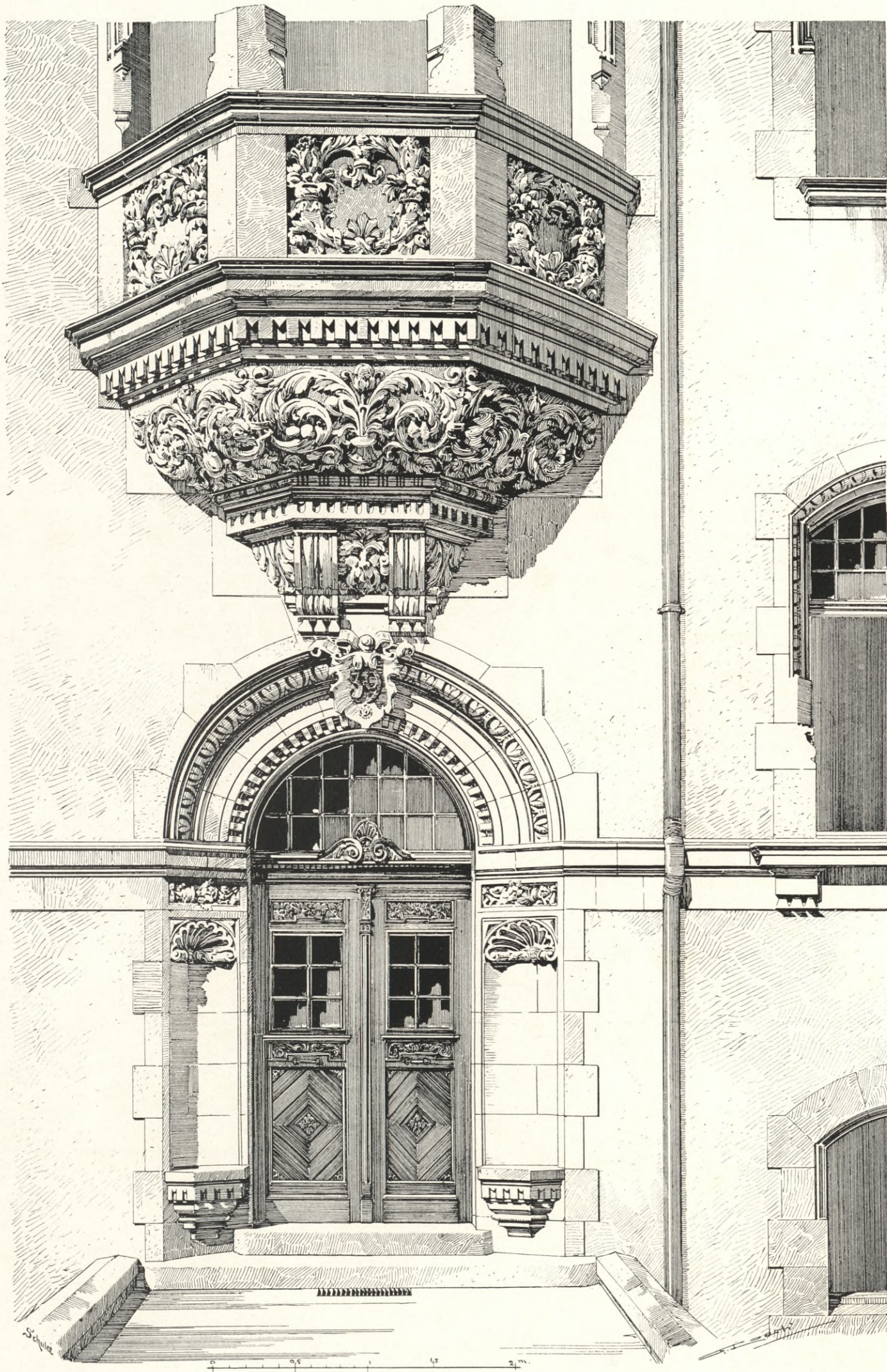
Wohnhaus Ecke Lessing- und Flensburgerstrasse in Berlin; erbaut von Solf & Wichards, Architekten daselbst. 2. Portal.
