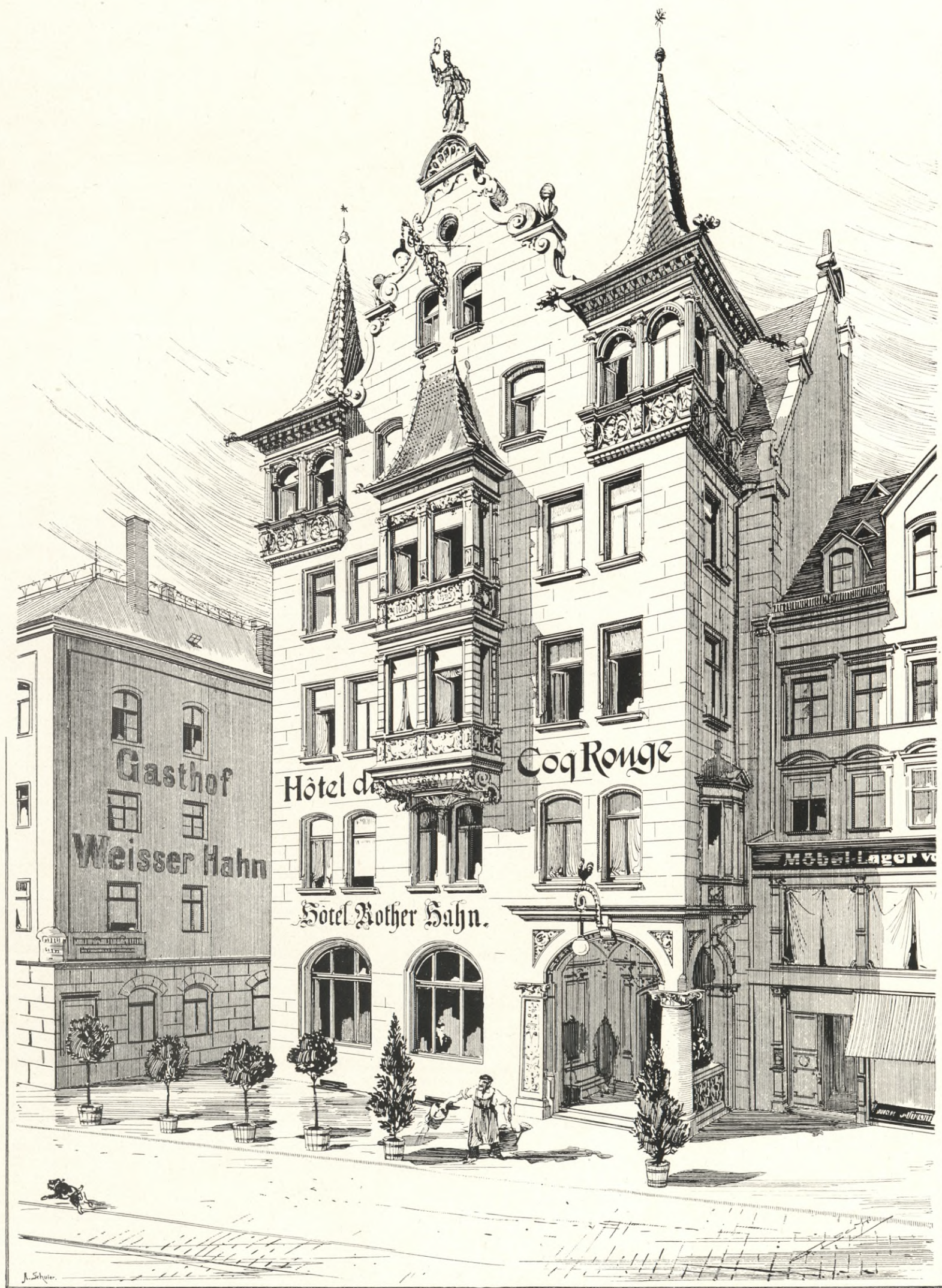
Hotel „Rother Hahn“ in Nürnberg; erbaut von Architekt Georg Richter daselbst.
