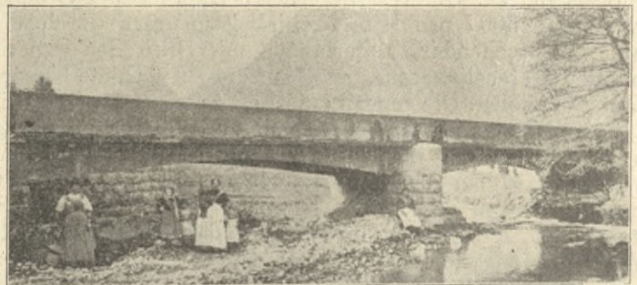
Fig. 9. Canalbrücke über die Inze bei Evillard (Schweiz).
