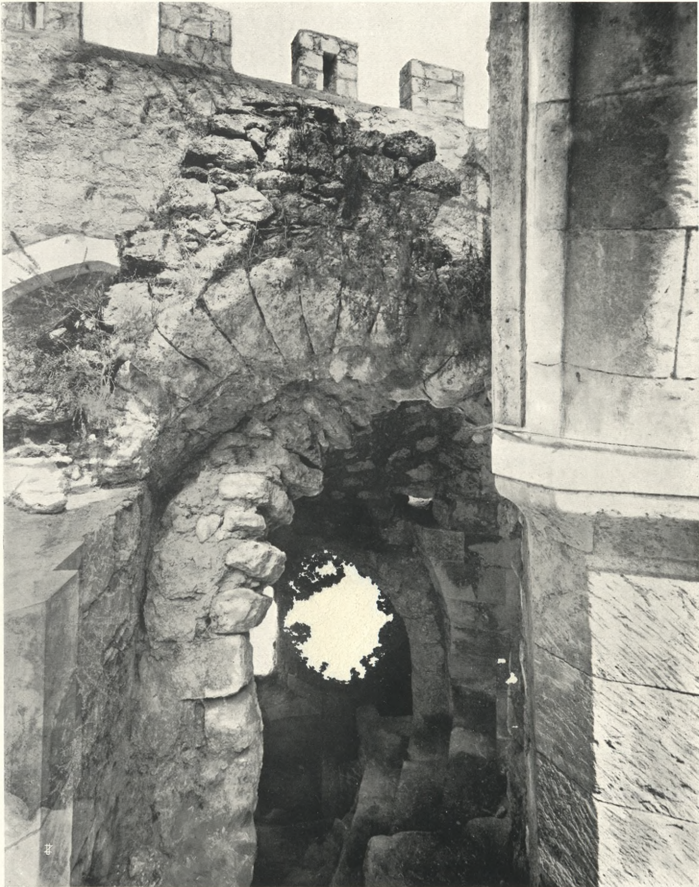
ACCESSO ESTERNO AD UNA SCALETTA CHE DISCENDE NEI SOTTERRANEI ED ACCESSIBILE ANCHE DALLA SALA DEI BARONI
