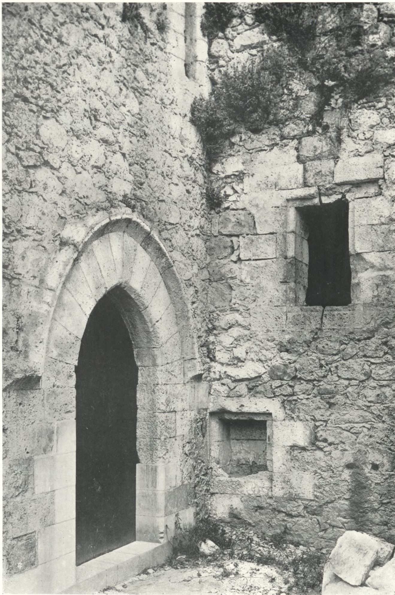
PORTA ESTERNA DI ACCESSO ALLA SECONDA SALA - CISTERNA - FILTRO PER ACQUA
