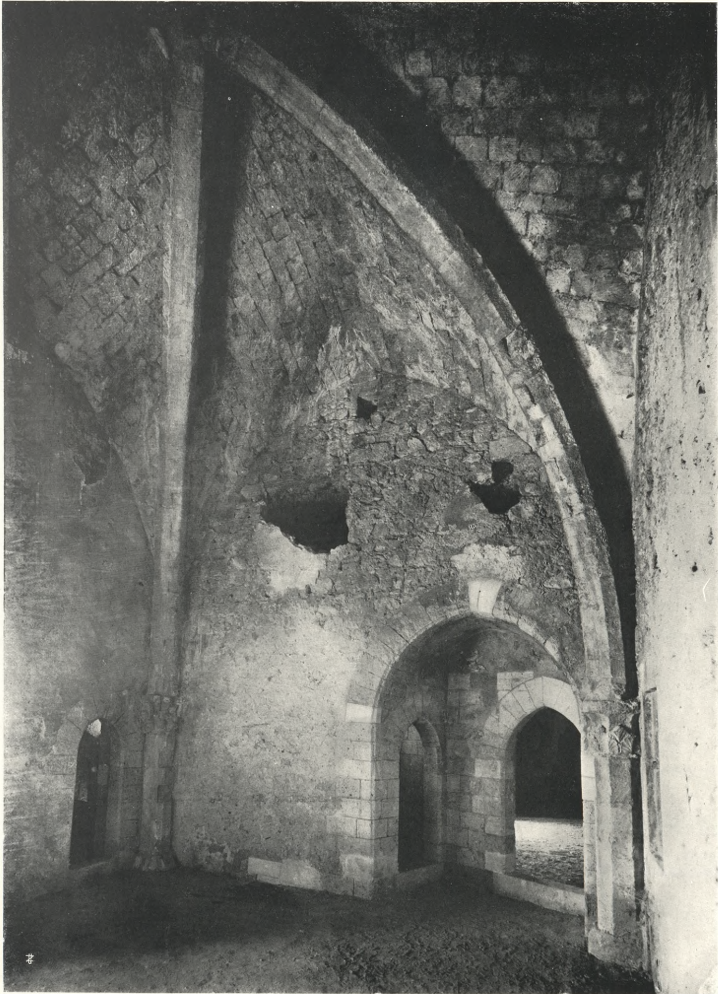
SECONDA SALA — VANO DI ACCESSO ALLA TORRETTA SPORGENTE; ACCESSO AI SOTTERRANEI; INGRESSO ALLA TERZA SALA
