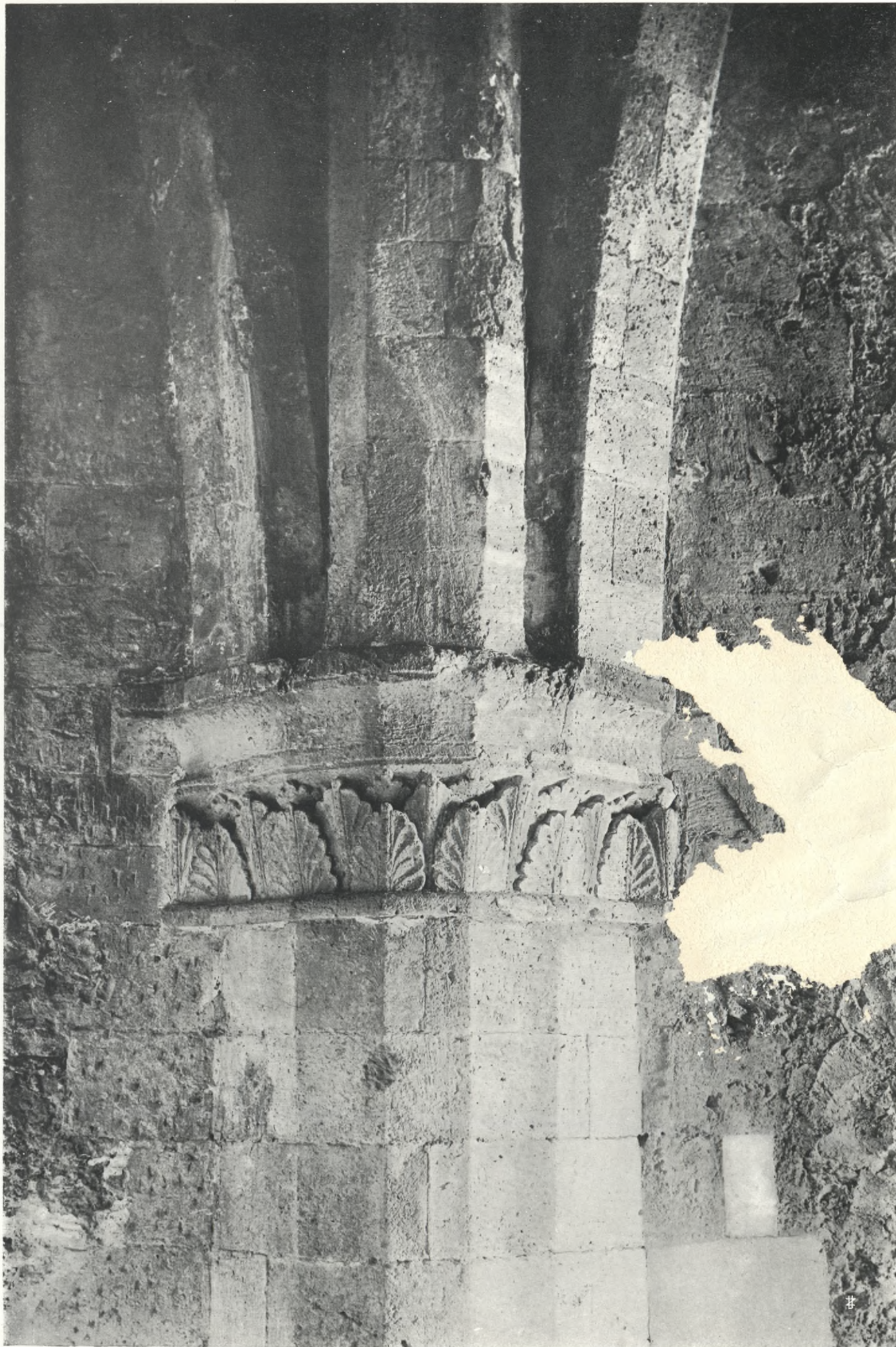
CAPITELLO DI PILASTRO TRIPLO NELLA TERZA SALA COPERTA CON VÔLTE A CROCIERA
