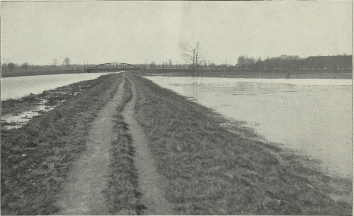
Abb. 4. Alter Zustand bei der Waghalsbrücke. Bei Hochwasser wurden alljährlich weite Flächen auf beiden Seiten der Emscher unter Wasser gesetzt, die Entwässerung bei Mittelwasser war mangelhaft.
