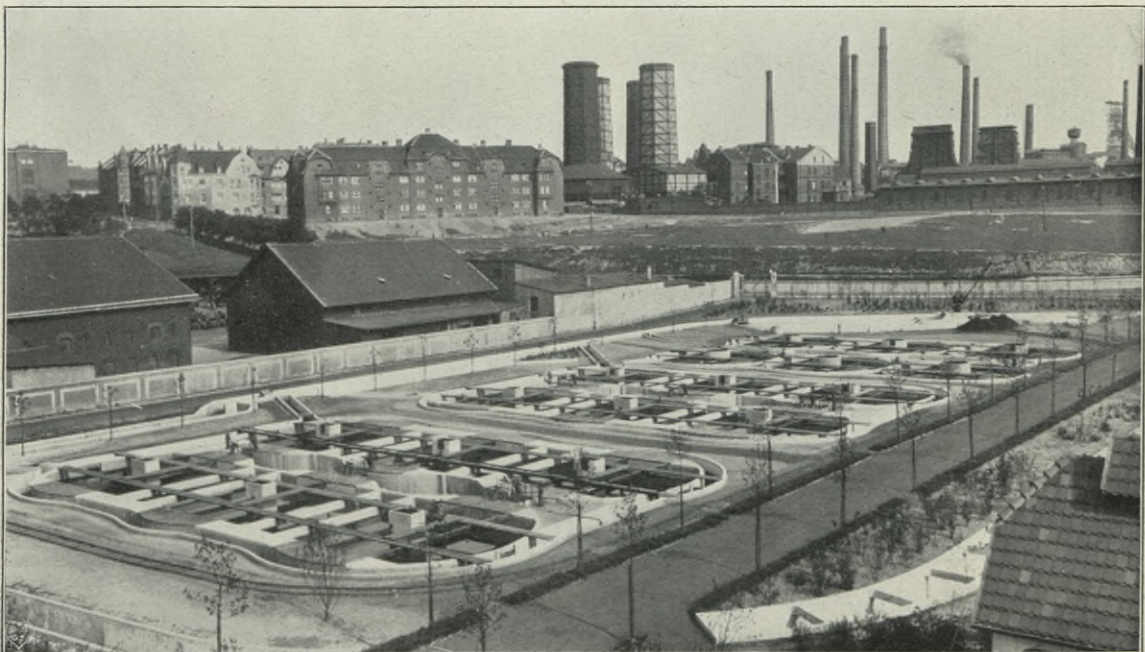
Abb. 29. Kläranlage Essen-Nord, Schaubild. Im Hintergrunde das Rheinisch-Westfälische Elektrizitätswerk und Arbeiterwohnhäuser.
