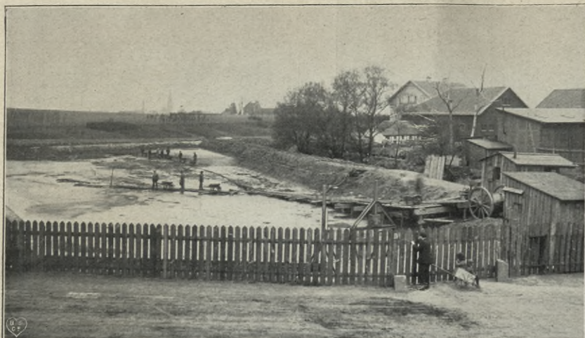
Abb. 55. Nachklärbecken der früheren Kläranlage bei Altenbergs Hof in Essen. Der Kalkgehalt des Abflusses aus der alten Rothe-Röckner-Anlage mußte nachträglich ausgefällt werden. Den Raum dieser Nachklärbecken nimmt jetzt ungefähr die Kläranlage Essen-Nord ein (vergl. Abb. 28 u. 29).
