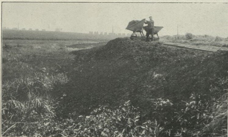
Abb. 54. Schlamm-lager-platz Bochum. Wo der Schlamm nicht landwirtschaftlich verwertet werden kann, wird er zum Auffüllen von Gelände benutzt, wie es wegen der Bodensenkungen im Emsergebiete meist billig zur Verfügung steht.
