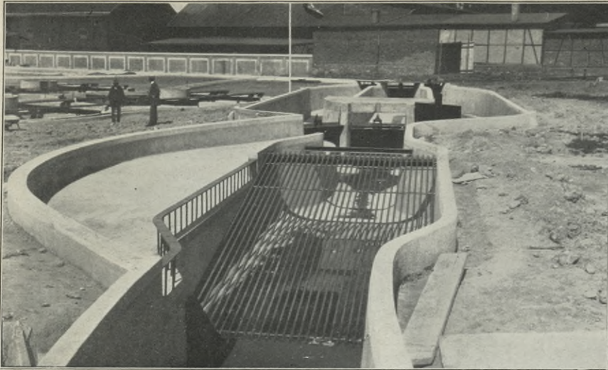
Abb. 34. Grobrechen der Kläranlage Essen-Nord. Der Rechen hat nur den Zweck, grobe Sperrstoffe zurückzuhalten, die den Betrieb der Kläranlage stören könnten. Alle fäulnisfähigen Stoffe werden möglichst durch die Rechen hindurchgetrieben. Der Rechen muß sehr flach liegen, damit der Durchflußquerschnitt nicht verringert wird und kein Rückstau eintritt. Zur Sicherheit ist außerdem noch ein Umlauf mit ganz weitem Gitter eingebaut.
