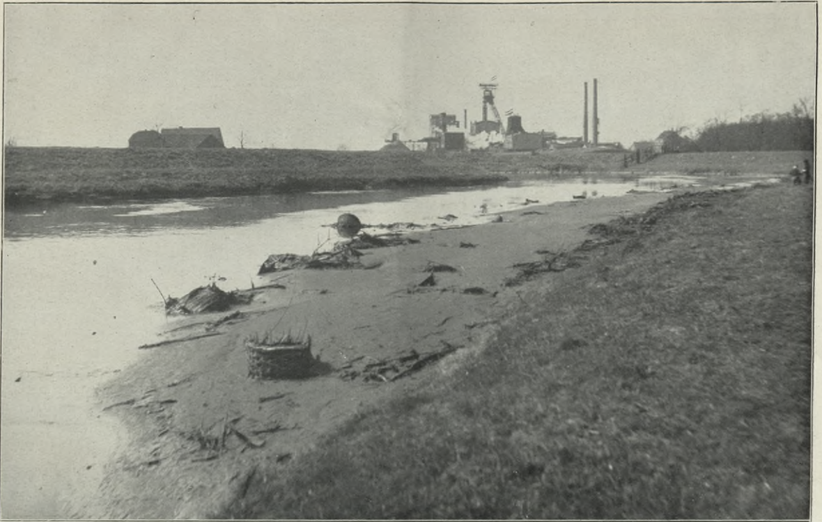
Abb. 6. Das alte Emscherbett oberhalb Zeche Vondern. Schlamm- und Unratansammlungen am rechten Ufer. Hohe Deiche schützten das gesunkene Gelände vor regelmäßigen Ueberflutungen; umso gefährlicher wurden die Ueberschwemmungen bei gelegentlichen Deichbrüchen, z. B. im Februar 1909.
