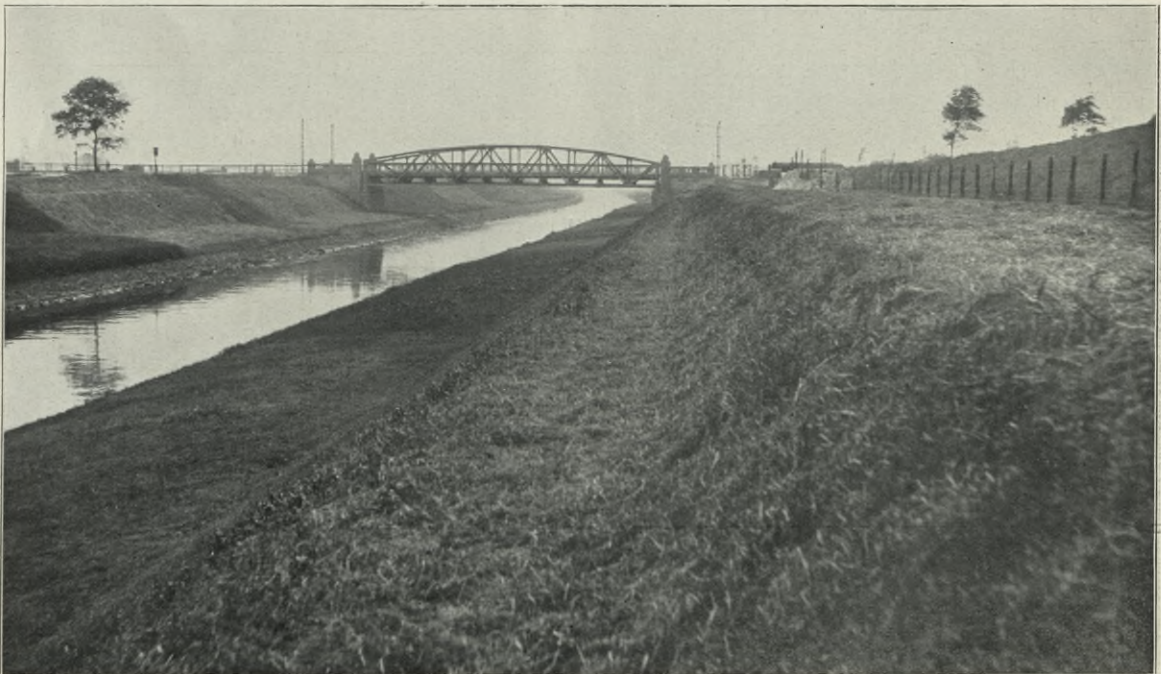
Abb. 5. Neues Emscherbett bei der Waghalsbrücke. Durch die Senkung des Wasserspiegels um 4 m hat die Gemeinde Osterfeld Vorflut für ihre Kanalisation erhalten.
