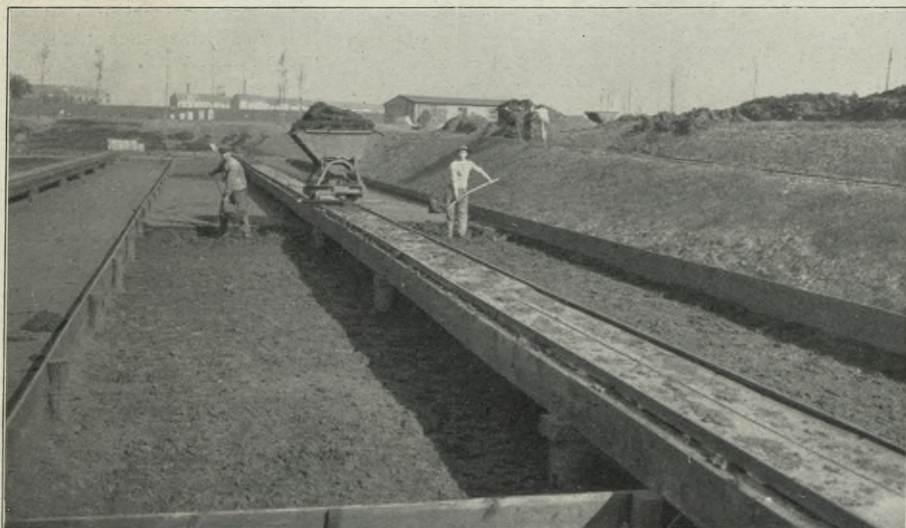
Abb. 48. Dasselbe. Der Schlamm wird am 4. Tage abgefahren. Die durchschnittliche Trockenzeit des Schlammes bei den Anlagen im Emschergebiete beträgt 6 Tage.
