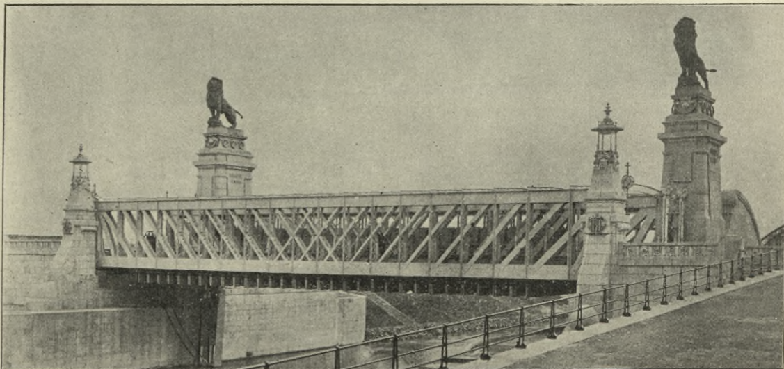
Fig. 7. Absperrwerk in Nussdorf.
