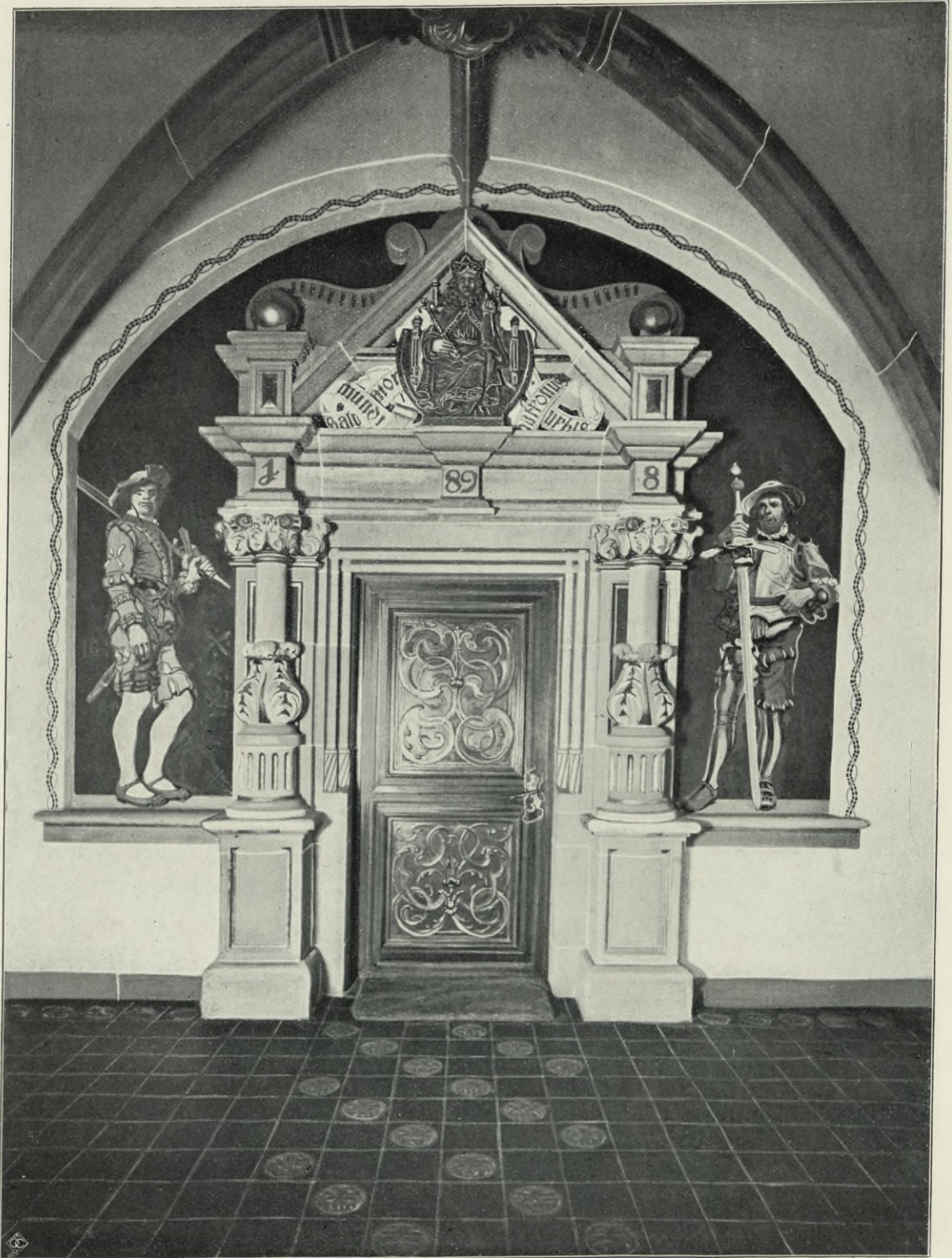
(Abbildung 25) Eingangstür an der Treppenhalle zum großen Sitzungssaal.
