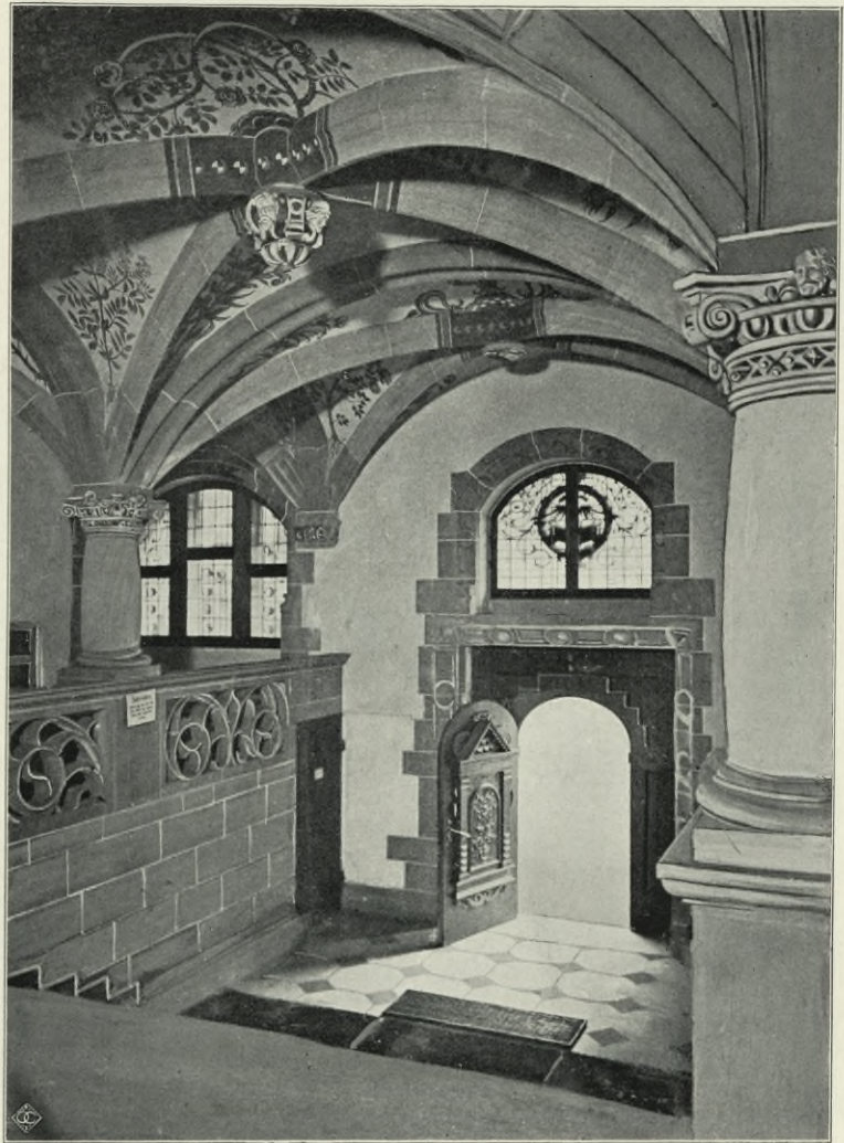
(Abbildung 17) Innenansicht der Haupteingangshalle vom Burgplatz aus.
