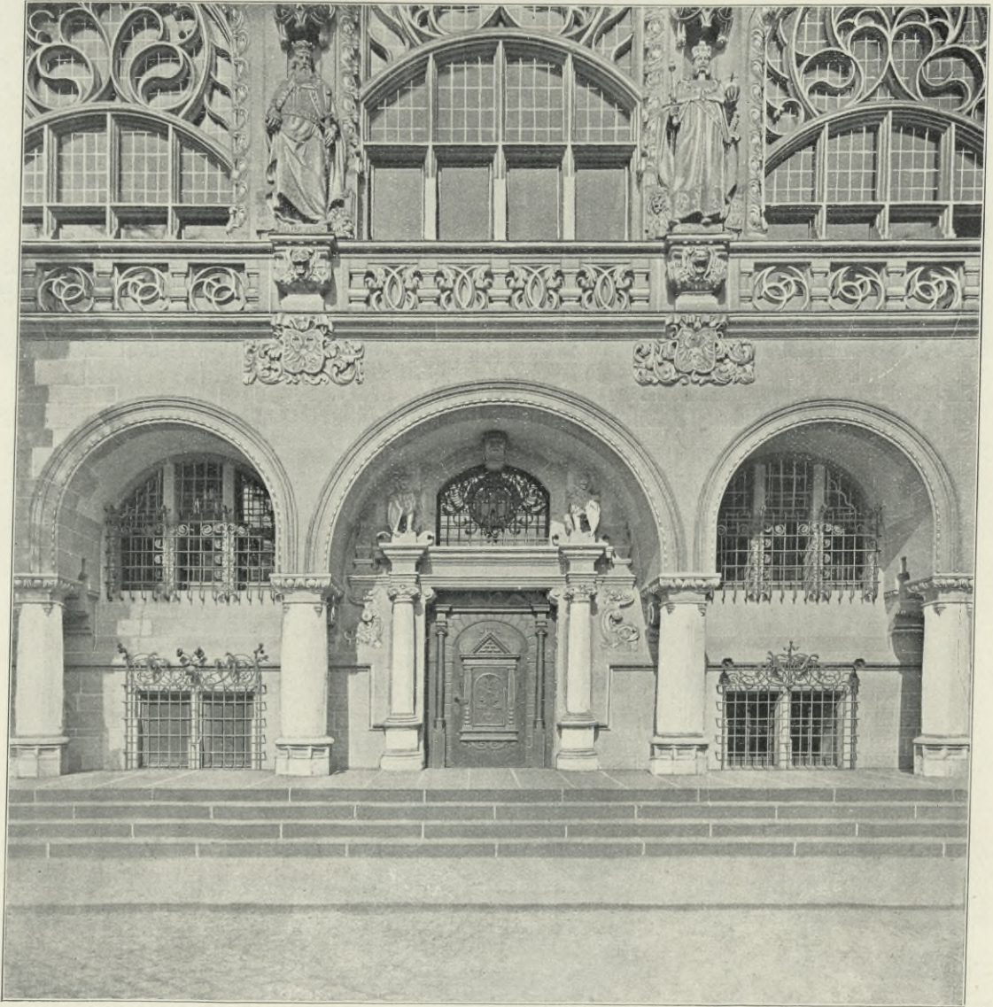
(Abbildung 16) Außenansicht des Einganges am Burgplatz.
