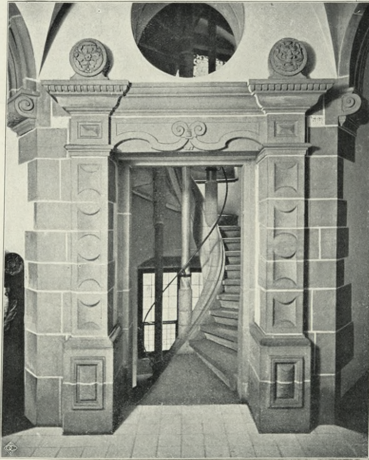
(Abbildung 20) Eingang vom Korridor zur Wendeltreppe.
