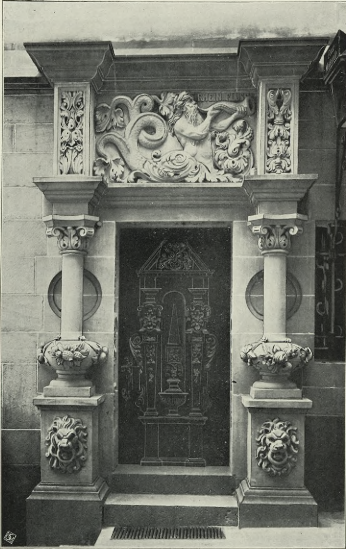
(Abbildung 53) Eingangstür zur Brandwache im Torbogenhof.
