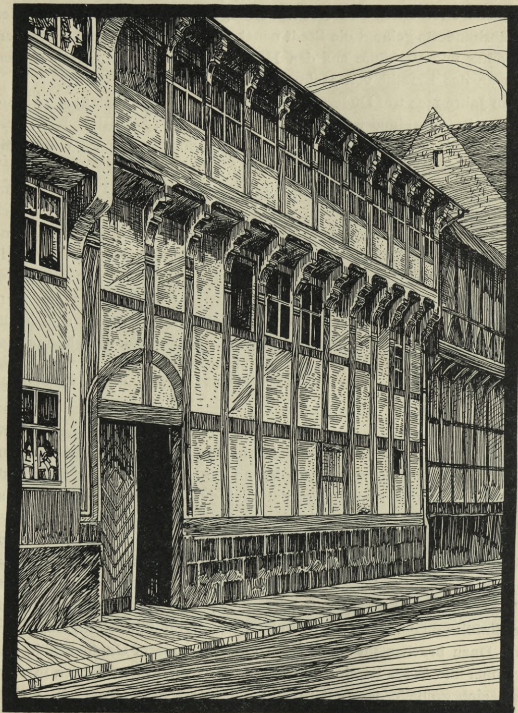
Abb. 10. Einbeck. Münsterstraße, Hintergebäude der Ratsapotheke (um 1550).
