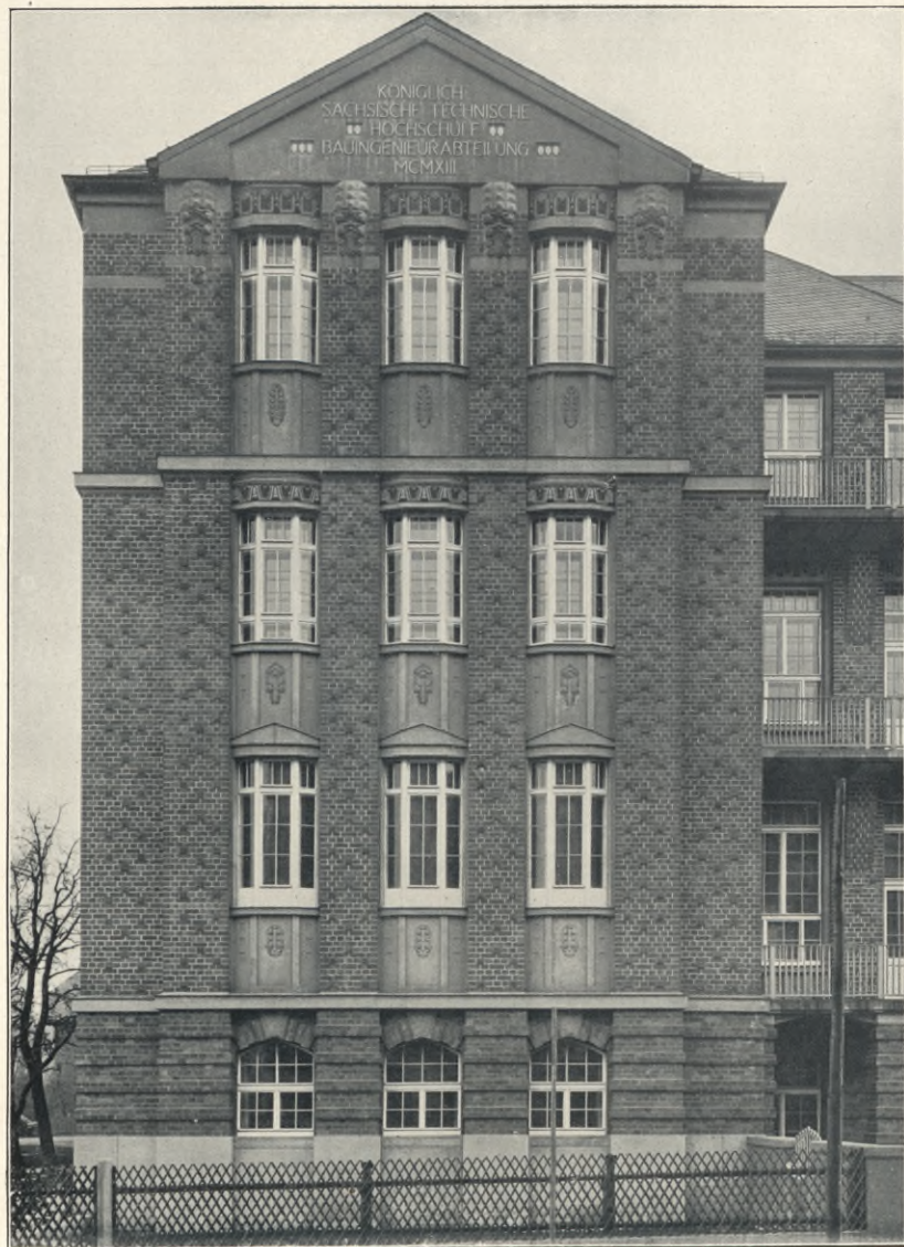
Nordwestliches Risalit an der George-Bähr-Straße.
