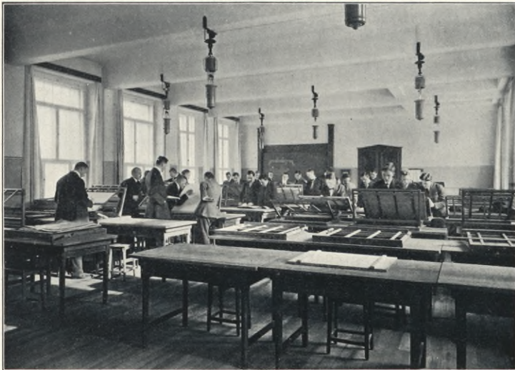
Zeichensaal für Eisenbrückenbau, erstes Obergeschoß 13.
