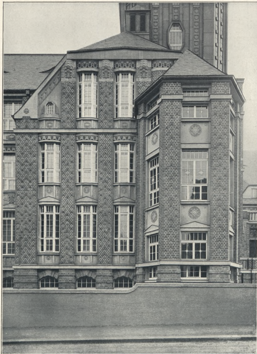
Treppenhausgiebel mit Treppenhaus „K“ an der George-Bähr-Straße.
