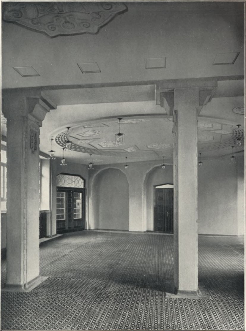
Vorraum XIX am Sedanplatz im ersten Obergeschoß.
