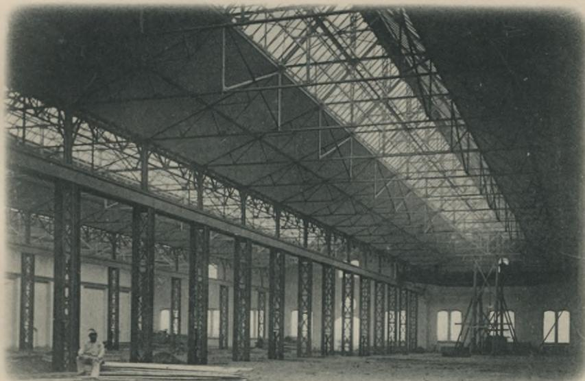
Locomotiv-Montirwerkstätte u. Kesselschmiede der Berliner Maschinenbau-Akt.-Ges.
