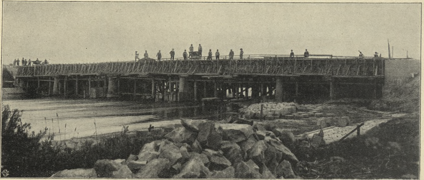
Abb. 5. Brücke über die Donau bei Blochingen
