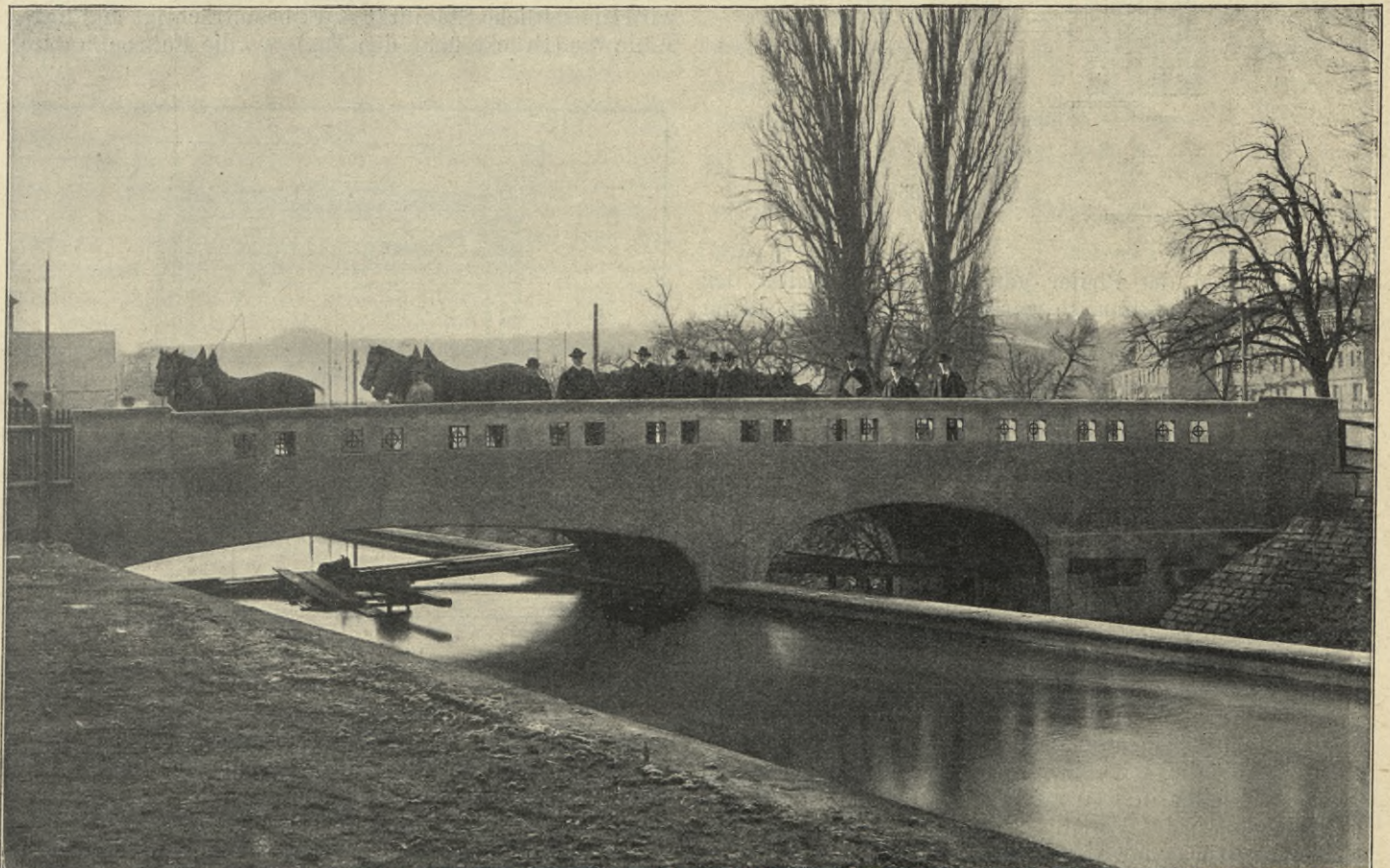
Abb. 34. Brücke über den Mühlgrünkanal in Cannstatt, ausgeführt 1905
