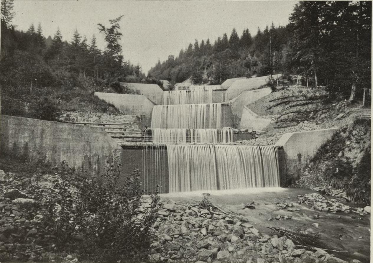
Abb. 98. **Verbauung der Gürbe.** Druckpartie oberhalb der Einmündung des Maienriesligrabens. Zustand im Jahre 1913 nach dem Ausbau mit Betonsperren.
