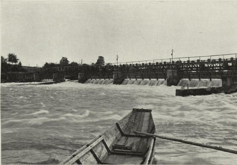
Abb. 43. Elektrizitätswerk Ruppoldingen. Ansicht des Stauwehres von unten mit Fischtreppe auf dem rechten Ufer.
