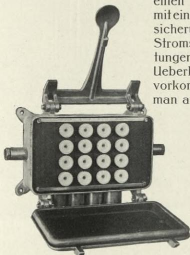
Abb. 45. Sicherungskasten
