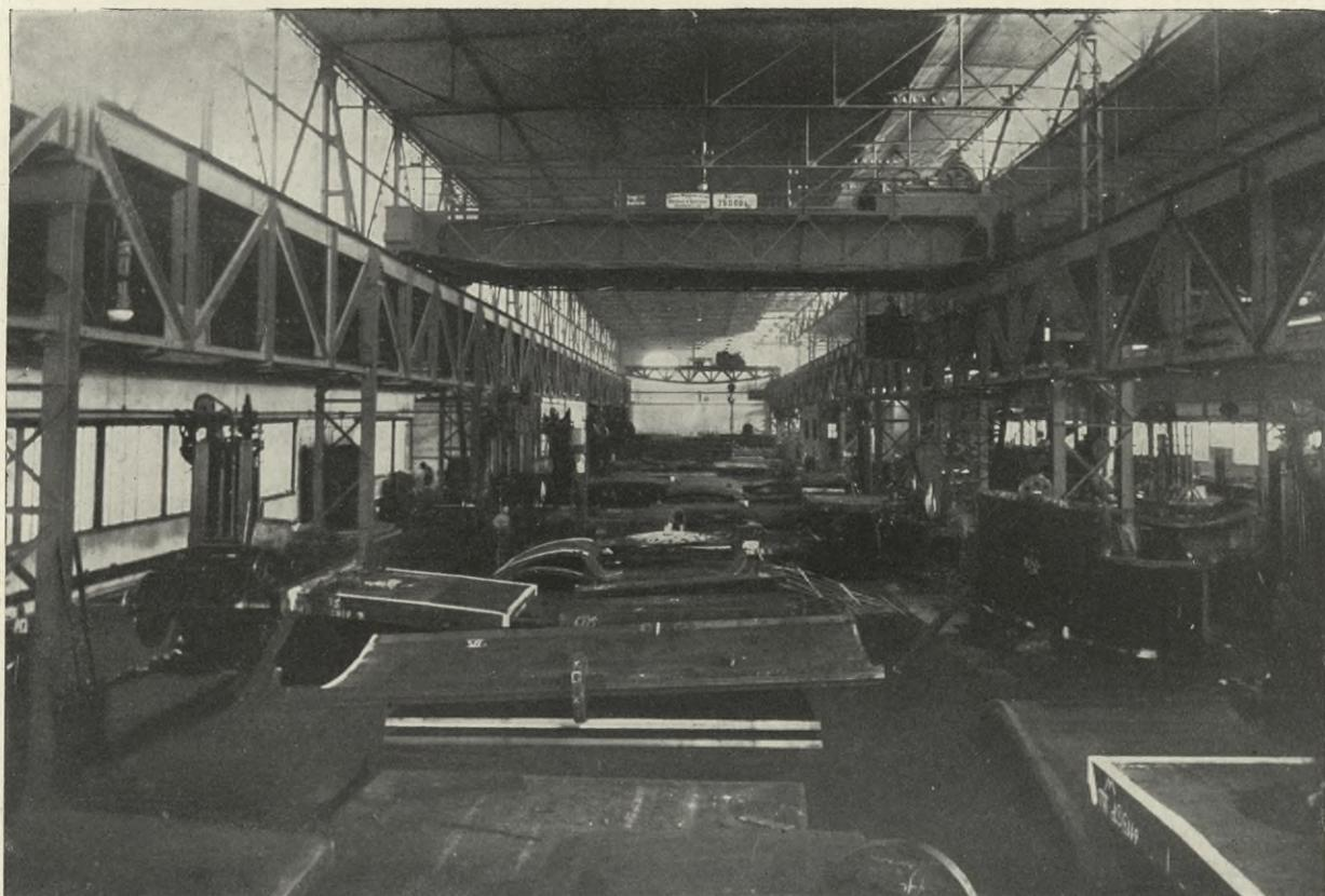
Abb. 22. Tiefefenanlage mit Stripperkran. Actien-Gesellschaft der Dillinger Hüttenwerke, Dillingen
