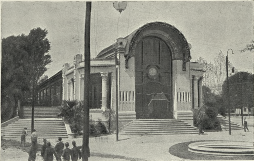
Station der elektrischen Hochbahn im Parco.
