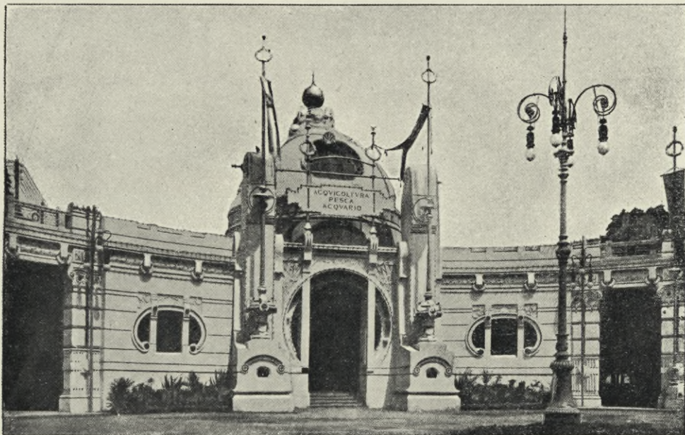
Eingang zum Fischereigebäude.
