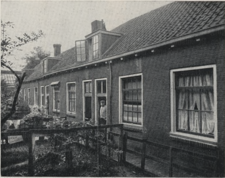
Abb. 61. Bebauung von Binnengelände, Wohnhof. Utrecht.
