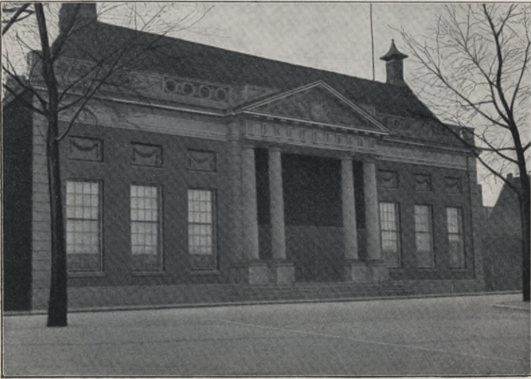
Abb. 77. Teijlershofje Haarlem, gestiftet durch Pieter Teijler van der Hulst, erbaut im Jahre 1787. Torgebäude am Koudenhorn.
