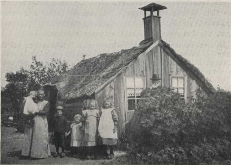
Abb. 99. Ältere Landarbeiterwohnung. Kollumerland (Friesland).
