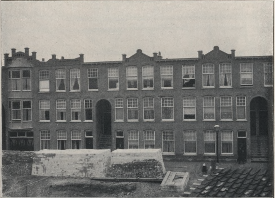
Abb. 19. Typus des Portalhauses (getrennte Wohnungseingänge). Haag.
