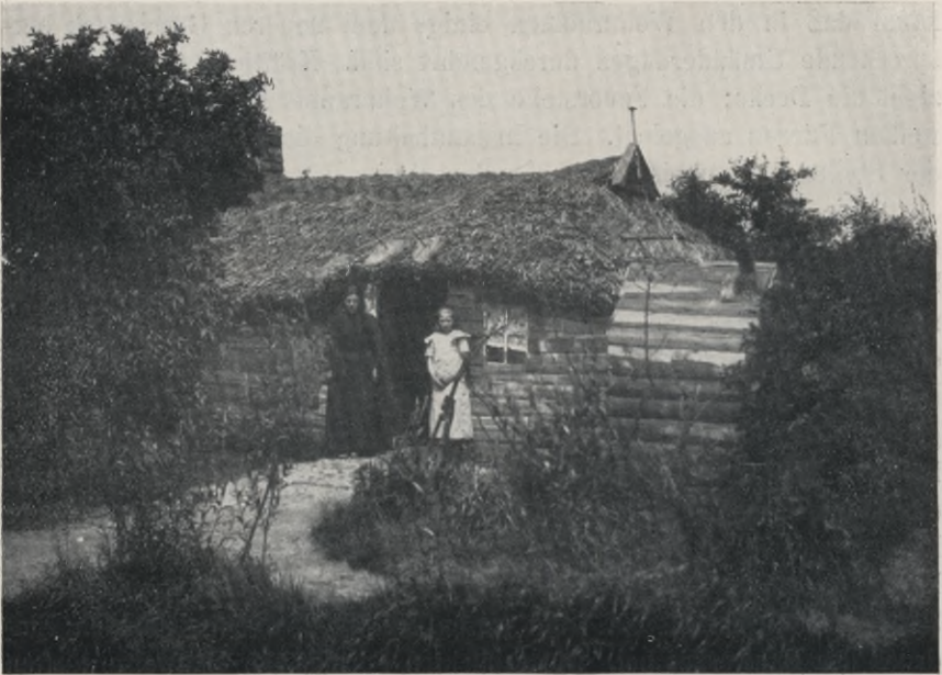
Abb. 98. Alte Landarbeiterhütte (Friesland).
