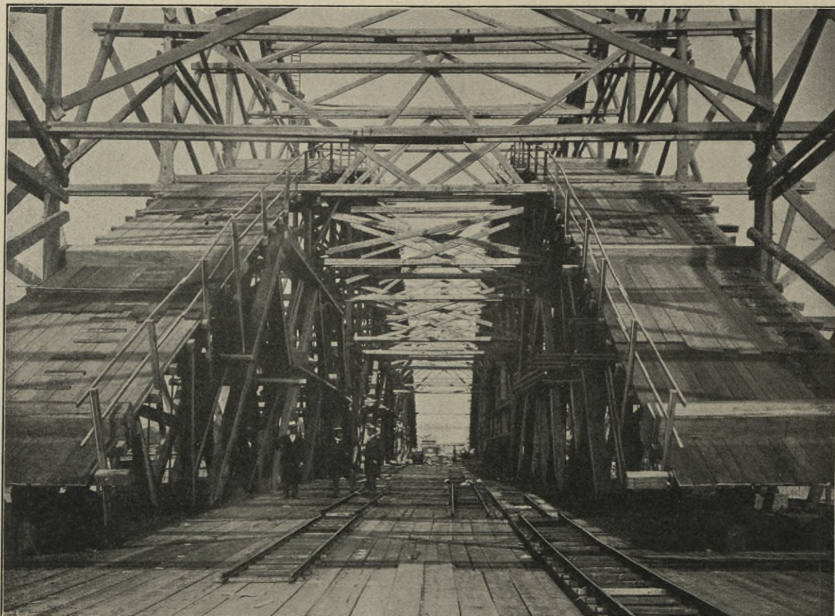
Blick auf das Innere des Montage-Gerüsts in Sahrbahnhöhe.
