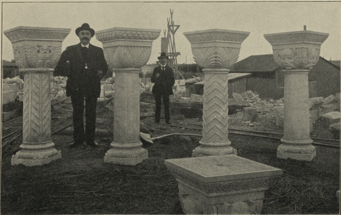
Teilungssäulchen der Fensteröffnungen in dem oberen Turmgeschoß der Portalbauten. (Menschliche Figur als Maßstab.)
