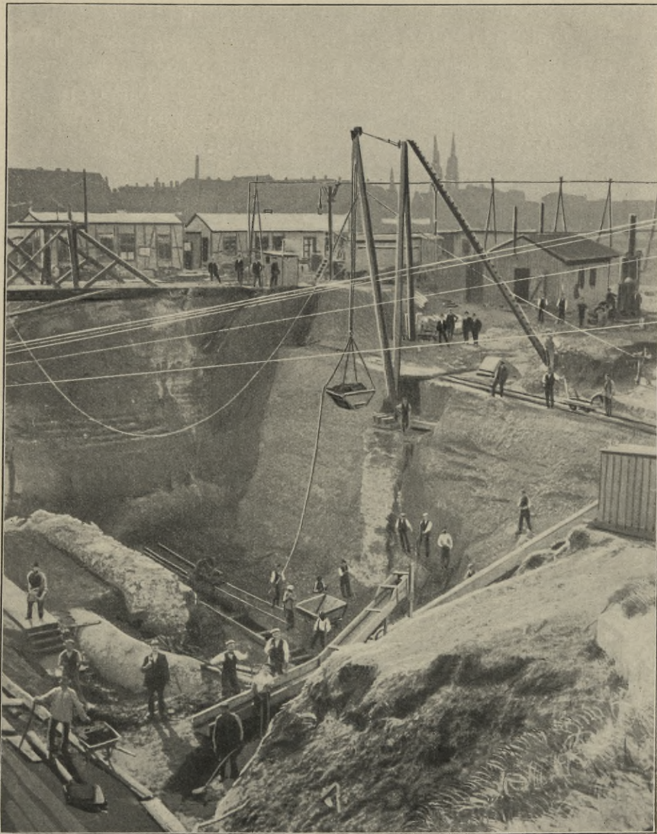
Ansicht der Baugrube für das linksseitige Widerlager.
