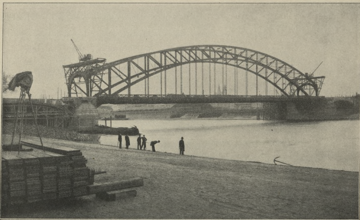
Die Eisenkonstruktion nach ihrer Ausrüstung.
