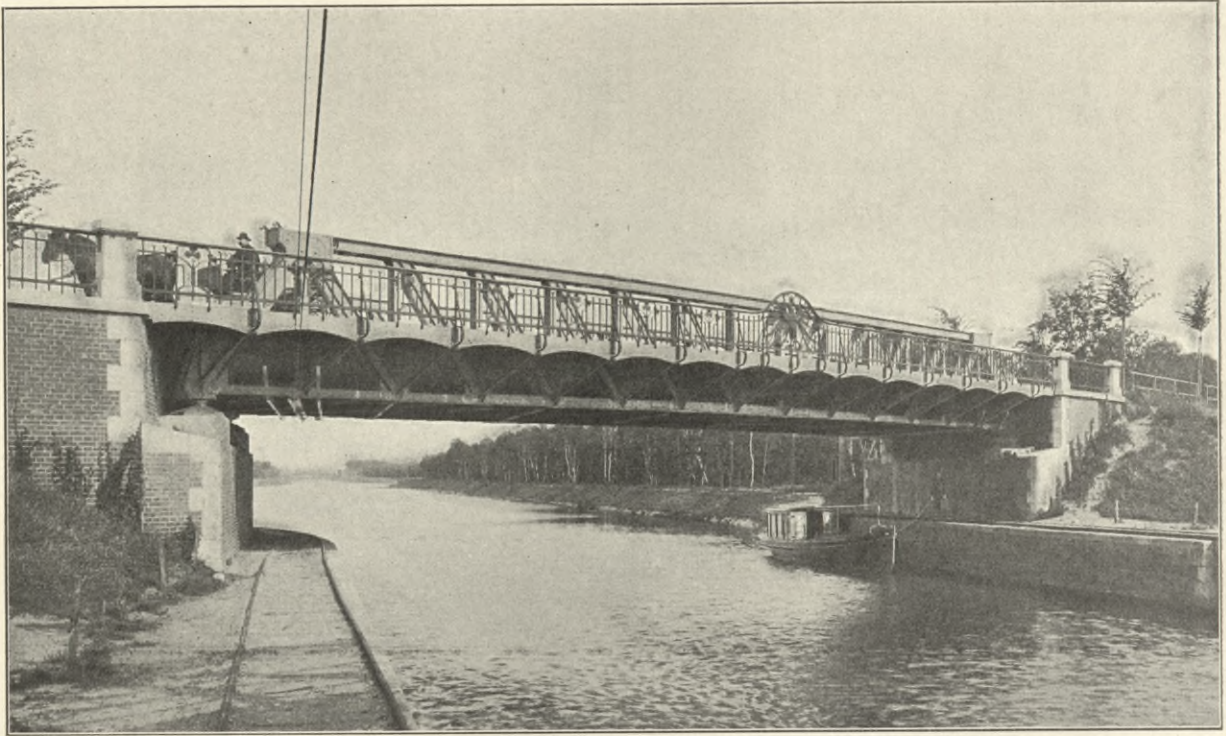
Adlergestellbrücke bei Adlershof.
