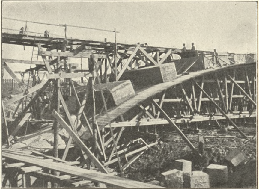
Chausseestrassenbrücke in Britz. Ausführung des Betongewölbes.
