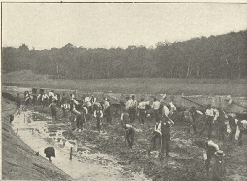
Erdarbeiten in Klein Machnow.
