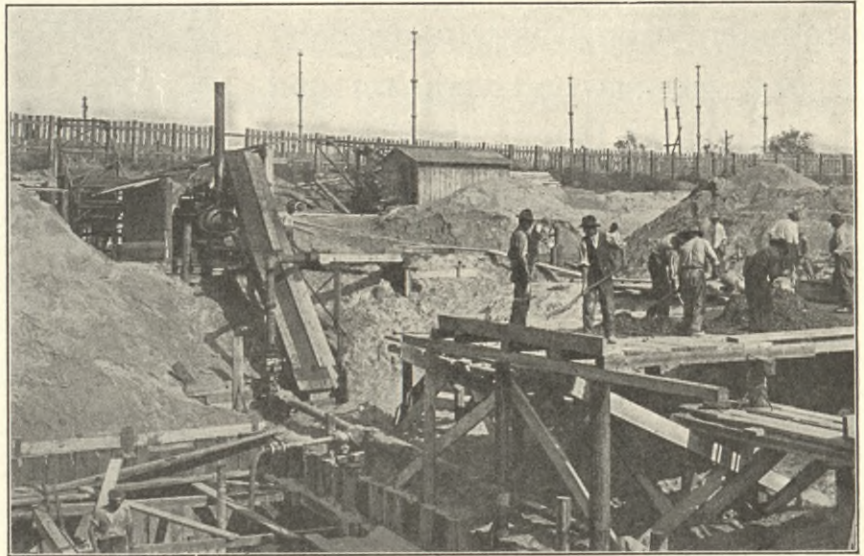
Betongründung des nördlichen Widerlagers der Chausseestrasßenbrücke in Britz.
