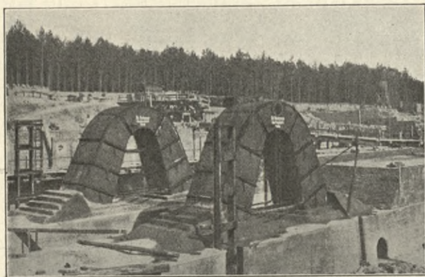
Unterhauptheber der Mittelmauer.
