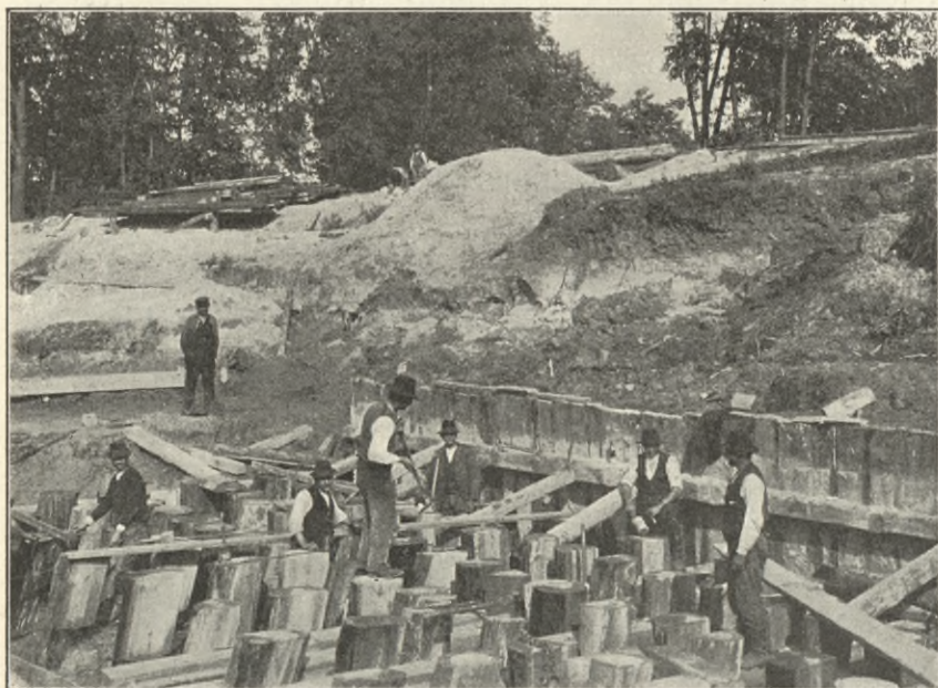
Giesensdorferstrassenbrücke. Anbringen der Zangen und Holme des Pfahlrostes.
