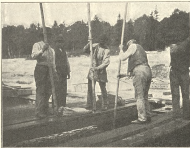
Luisenstrassenbrücke in Steglitz. Fundierung mittels Betonsäcke.
