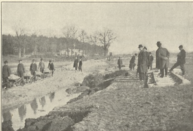
Dammschüttungen bei Klein Machnow.
