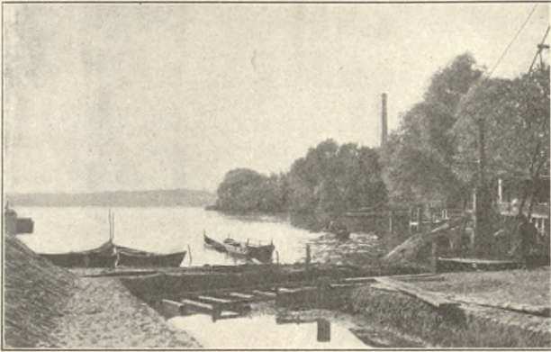
Kanalmündung in die Havel (vor dem Durchstich).
