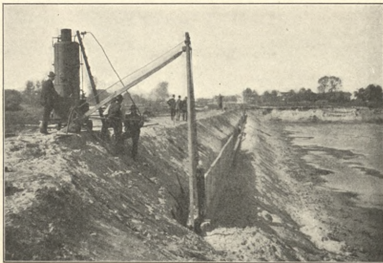
Rammarbeiten für die Uferbefestigung im Britzer Hafen.
