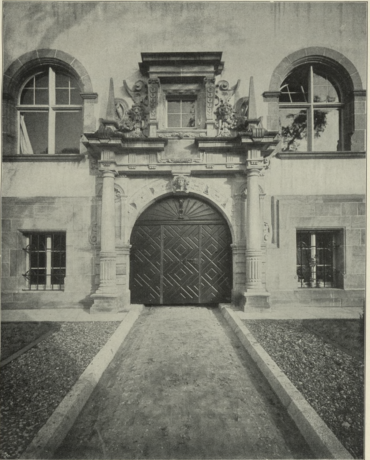
Abb. 13. Eingang von der Westseite.
