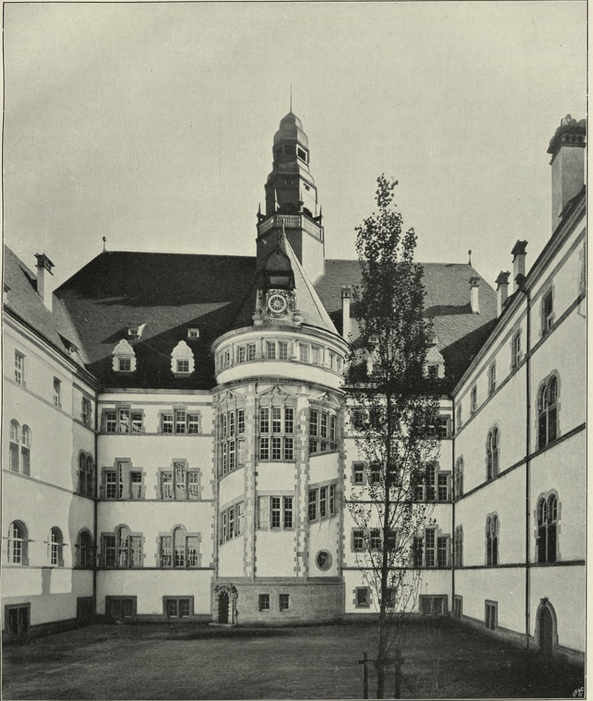
Abb. 11. Hofansicht mit Haupttreppenhaus.
