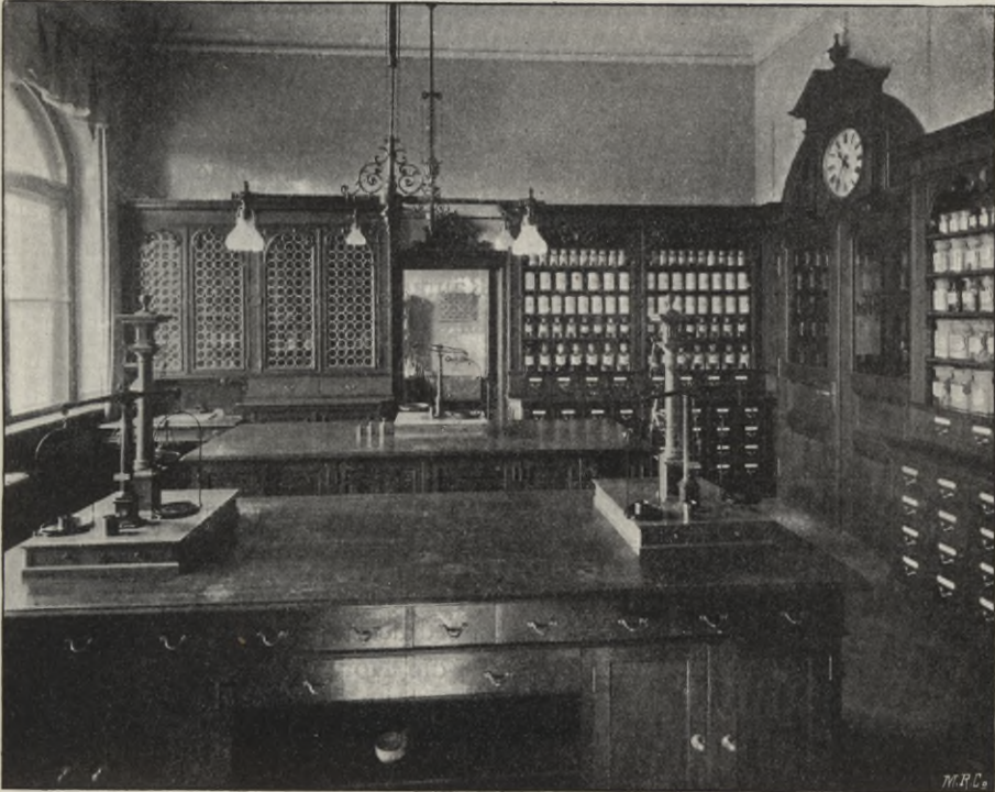
Verwaltungsgebäude, Offizin der Apotheke.
