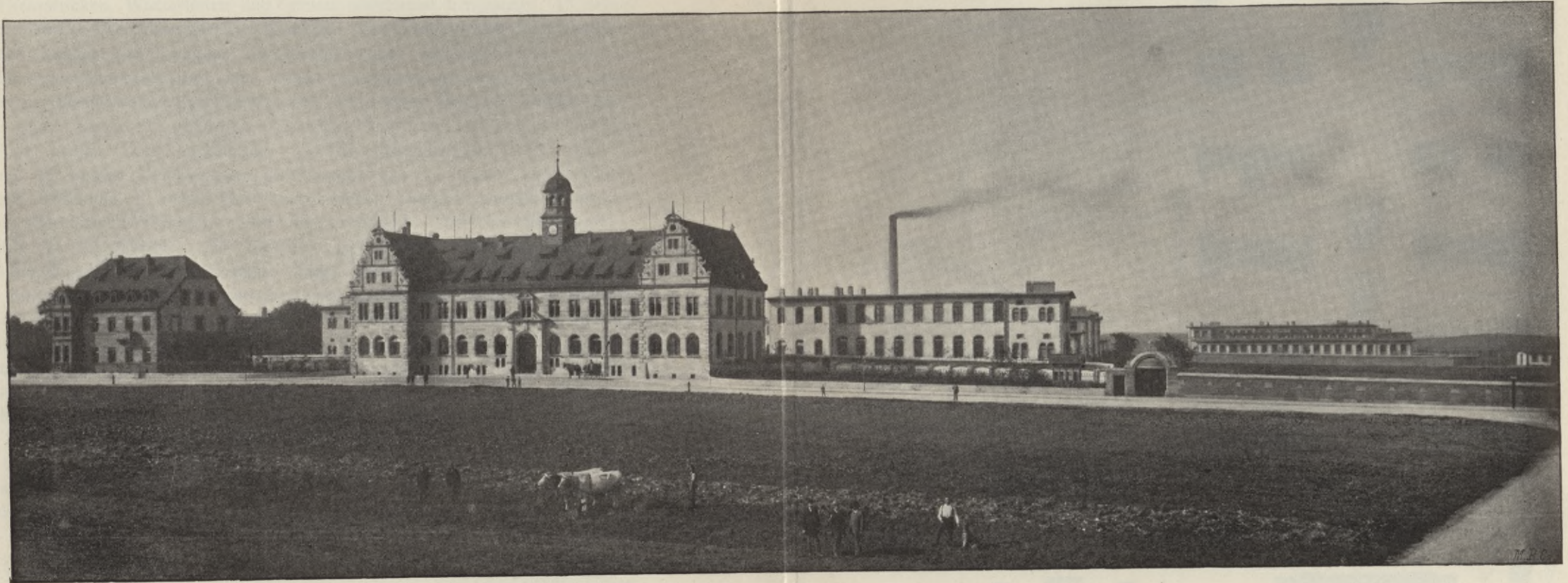
Ansicht des Krankenhauses an der Flurstraße.
