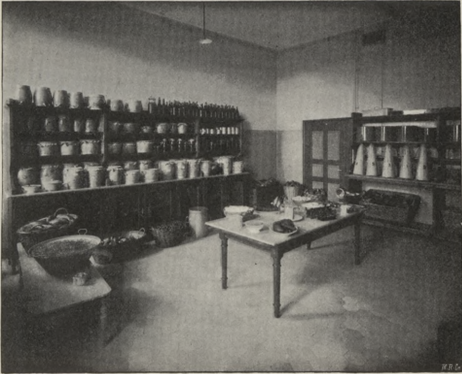
Wirtschaftsgebäude, Speisekammer 7 der Kochküche.
