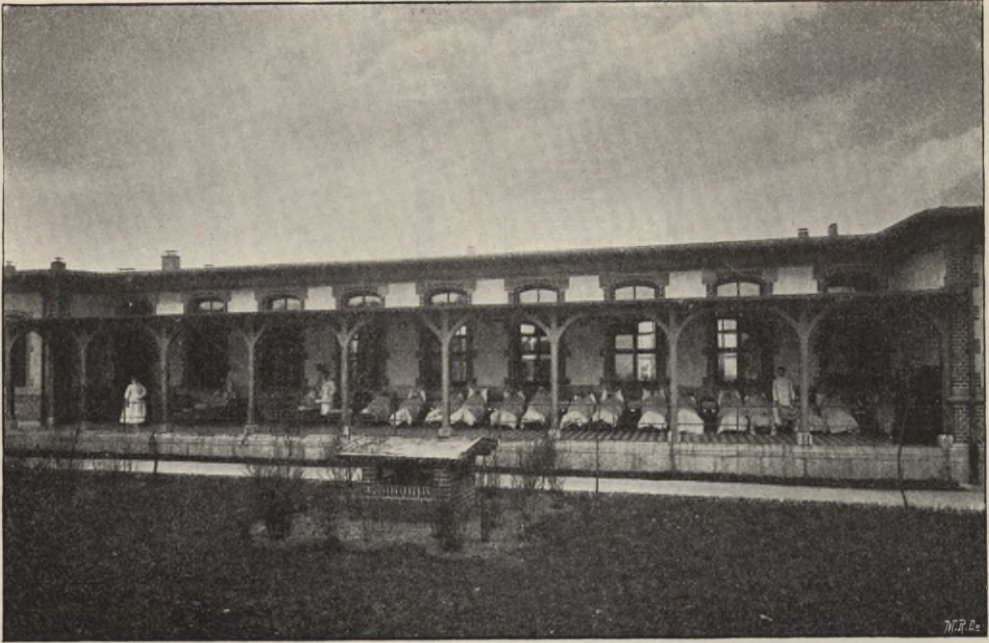
Krankenbau Nr. 16, Liegerhalle.
