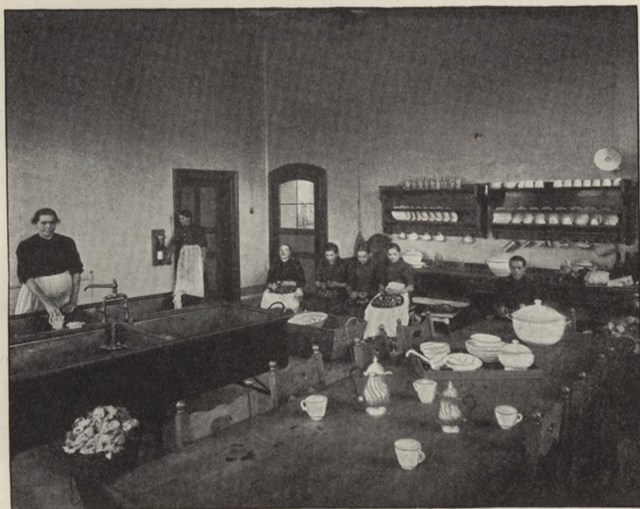
Wirtschaftsgebäude, Gemüseputzraum und Eßraum für das Küchenpersonal.
