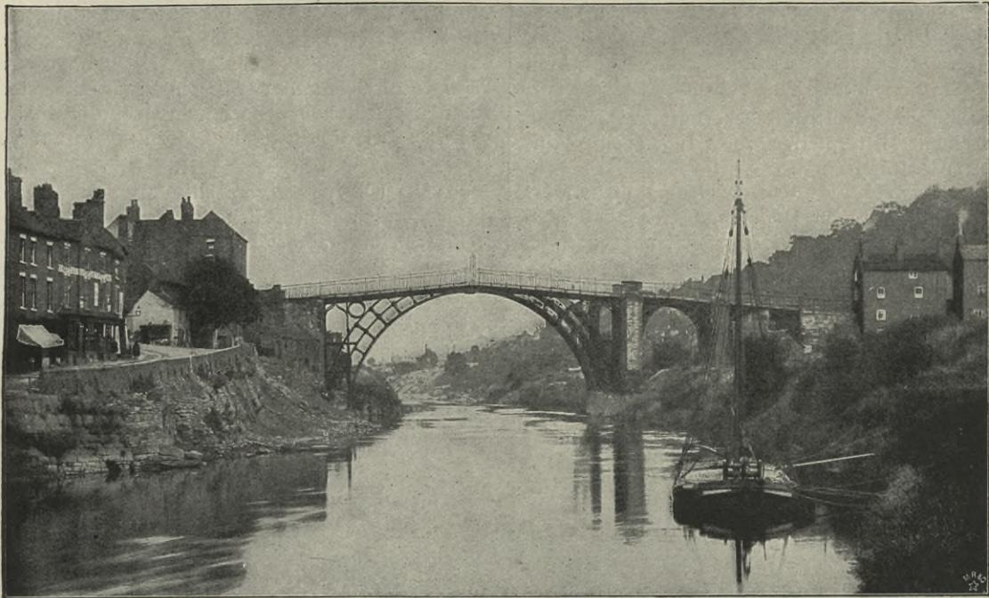
Fig. 9. Gusseiserne Bogenbrücke über den Severn bei Coalbrookdale.
