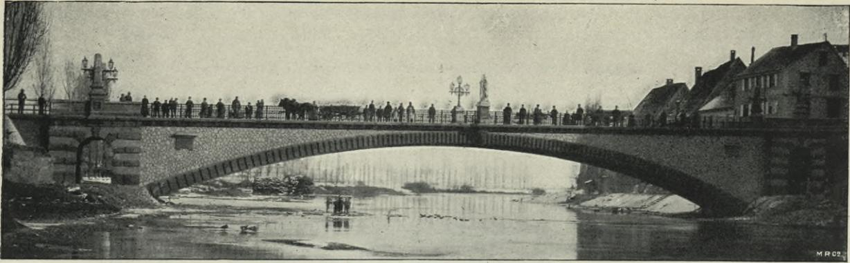
Fig. 46. Stampfbeton-Brücke über die Donau bei Munderkingen.
