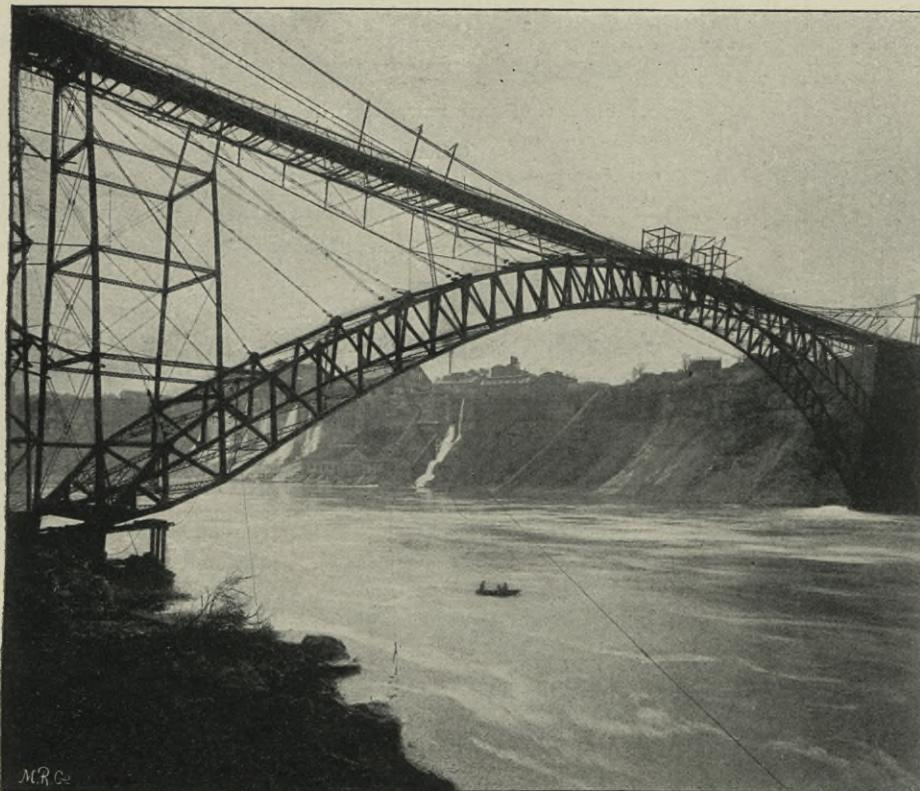
Fig. 30. Aufstellung der Niagara-Strassenbrücke bei Clifton.
