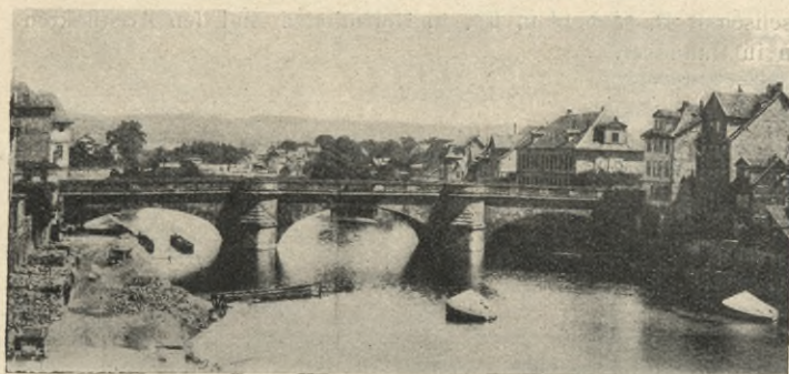
Abb. 10. Alte Fuldabrücke in Kassel.
