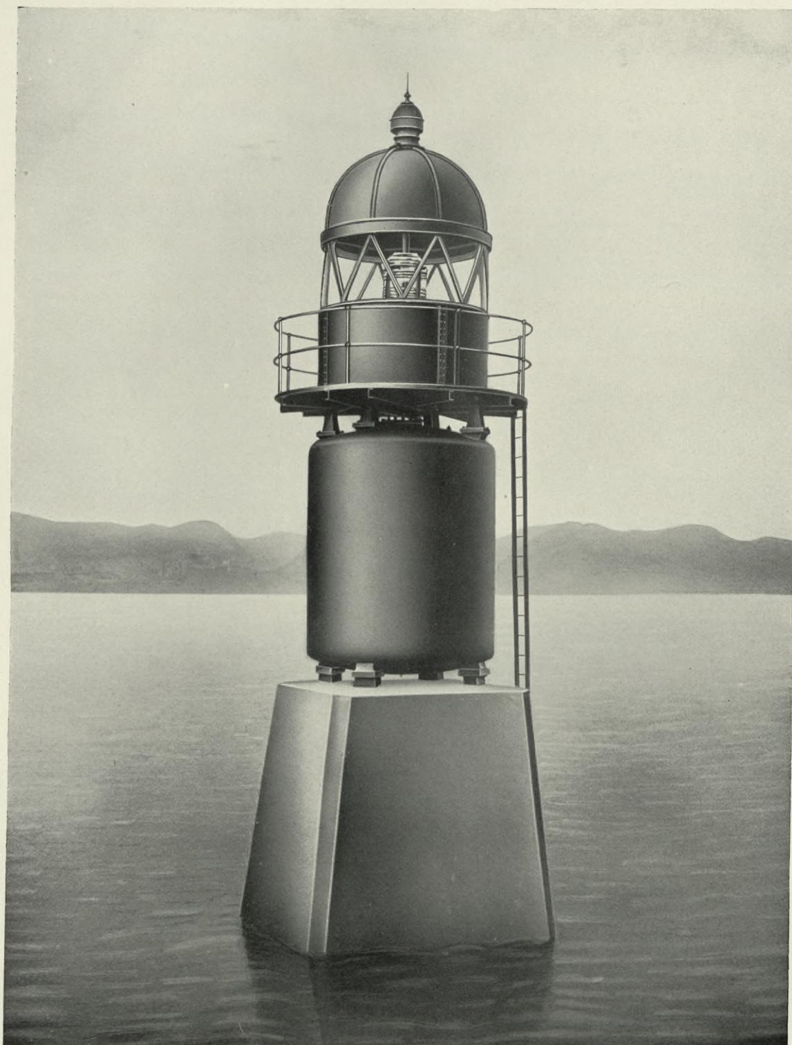
Leuchtbake für gepresstes Ölgas mit einem Gaskessel als Unterbau (Clyde, Glasgow)
