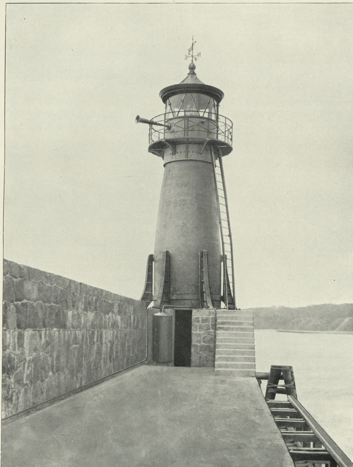
Leuchtbake für gepresstes Ölgas mit Nebelhorn und einem Gaskessel als Unterbau, Sassnitz auf Rügen
