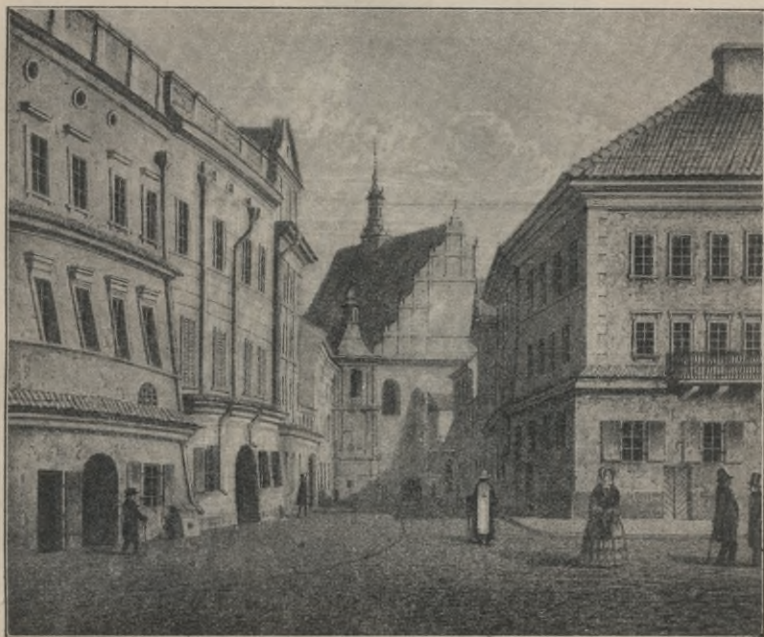
Rys 30. Lublin, Ulica Złota. Ściany domów skarpowate, silne odsadzki pokryte okapami. (Album Lerue r. 1858).
