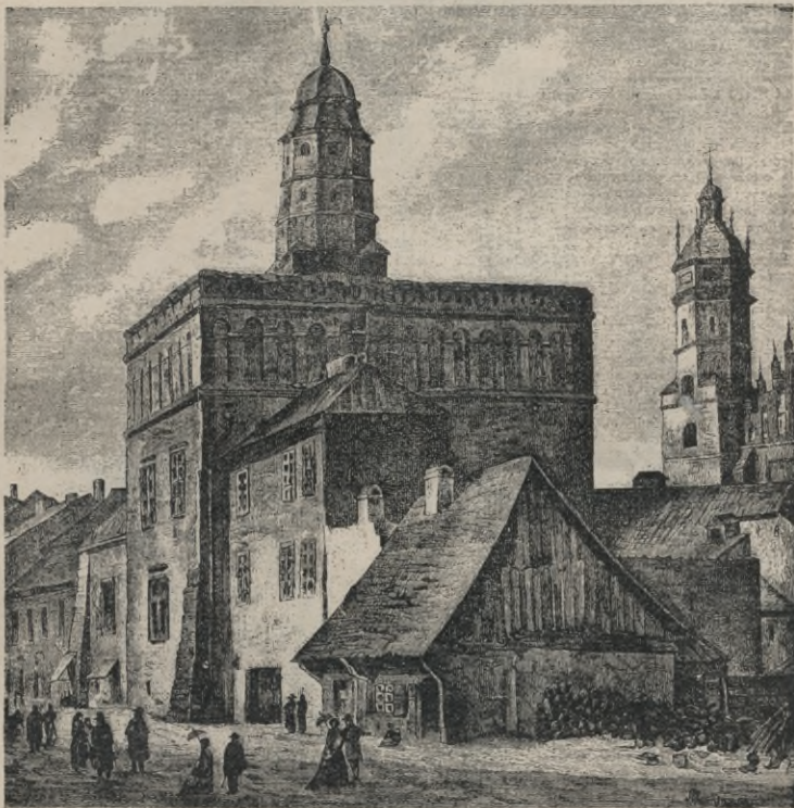
Rys. 51. Kraków, Ratusz na Kazimierzu z attyką i wieżą ośmioboczną na czworobocznej podstawie. W głębi wieża kościoła Bożego Ciała, tego samego zasadniczego układu (por. z rys. 48, 49 i 50).
