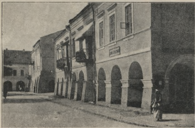
Rys. 31. Zamość. Domy podcieniowe ze słupami zbudowanymi skarpowato.
