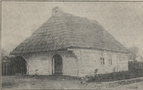
Rys. 12. Złoczew w Kaliskiem. Stara karczma z dachem przybówym na rysiach, ochraniającym podjazd. (Ze zbiorów Tow. Krajoznawczego).
