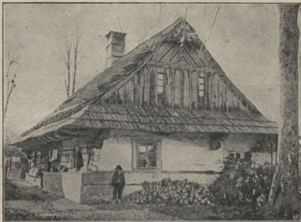
Rys. 14. Śląsk Austriacki, dom w Trzycieźu z r. 1801 ze szczytem i daszkiem przyźbowym. (Glogier. Budown. drzewne).
