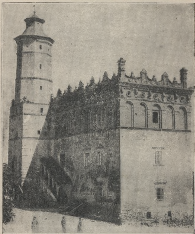
Rys. 50. Sandomierz. Ratusz z attyką i wieżą w kształcie ośmiobocznego słupa ustawionego na słupie czworobocznym. Na wieży liczne odsadzki pokryte okapami.
