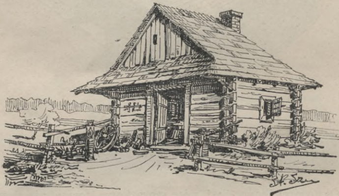
Rys. 11. Kuźnia w Lubelskiem z daszkiem przyźbowym, ochraniającym miejsce, na kucie koni przeznaczone.
