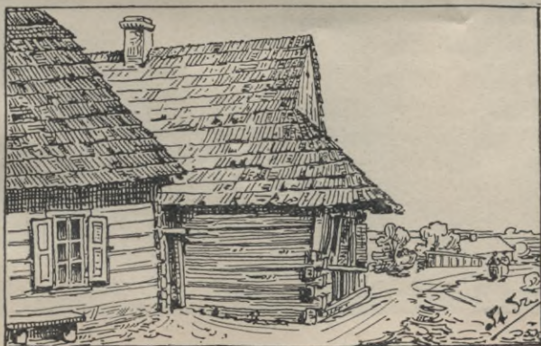
Rys. 55. Chata w Inowłodziu nad Pilicą, pow. Rawski. Trójkąt szczytowy silnie od lica ściany cofnięty.
