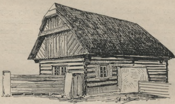
Rys. 53. Chata we wsiach koło Turnowa w Czechach. Trójkąt szczytowy lekko przed lico ściany wysunięty.
