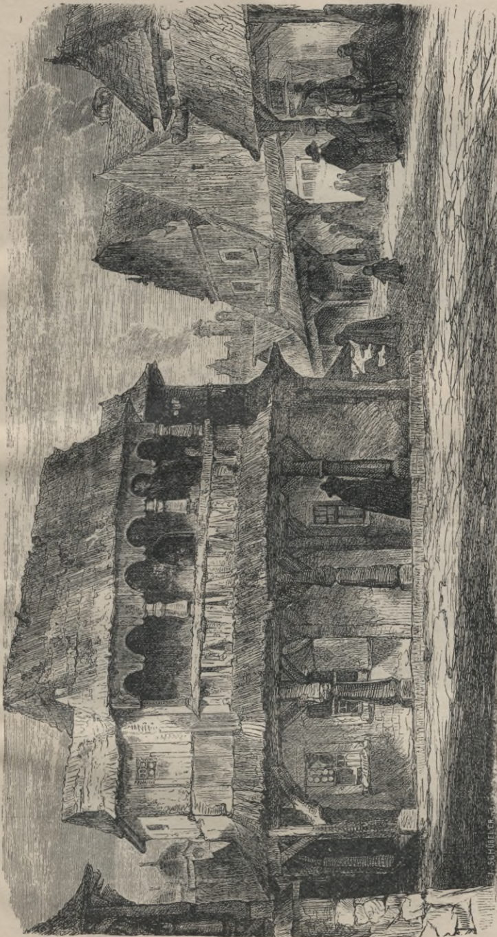
Rys. 17. Domy podcieniowe na rynku w Wiśniczu przed pożarem w 1863 r. (Rys. J. Matejki, Tyg. Ilustr. 1871). Daszki okapowe na podcieniach i przy szczytach, szczyty cofnięte od lica ścian, dachy łamane o jednakowej pochyłości nadają tym budowlom wybitny typ polski.
