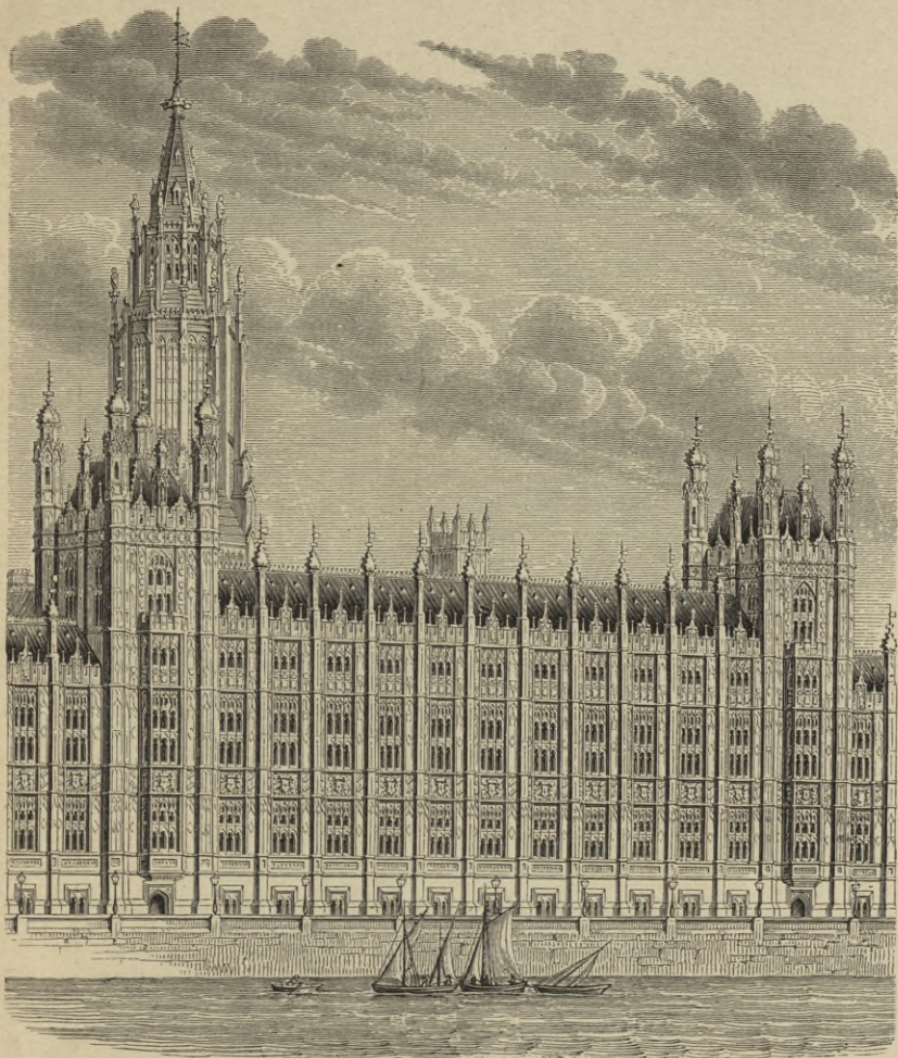
4. Parlamentsgebäude zu London. (Arch.: Charles Barry; 1795—1860.)
