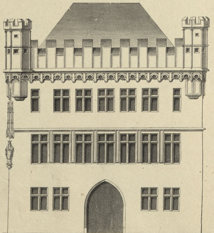
4. Das steinerne Haus zu Frankfurt a. M.
