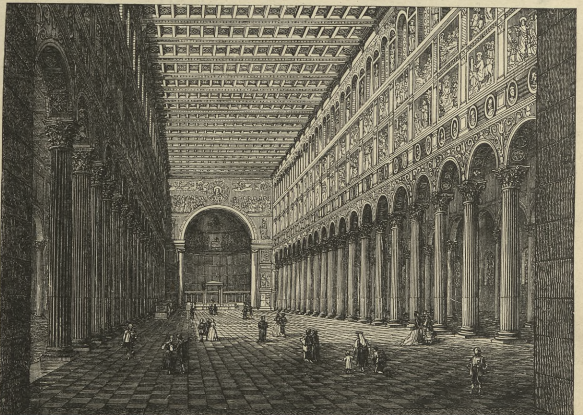
3. Inneres von S. Paolo vor den Mauern. Ende des 4. Jahrh. 1823 durch Brand zerstört, seitdem wieder aufgebaut.
