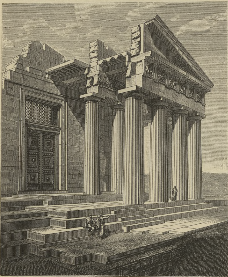
8. Aufbau der Nordostecke des Parthenon. (Nach Niemann.)
