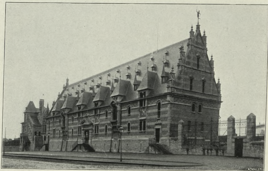
Station de Tournai. L'Entrepôt.
