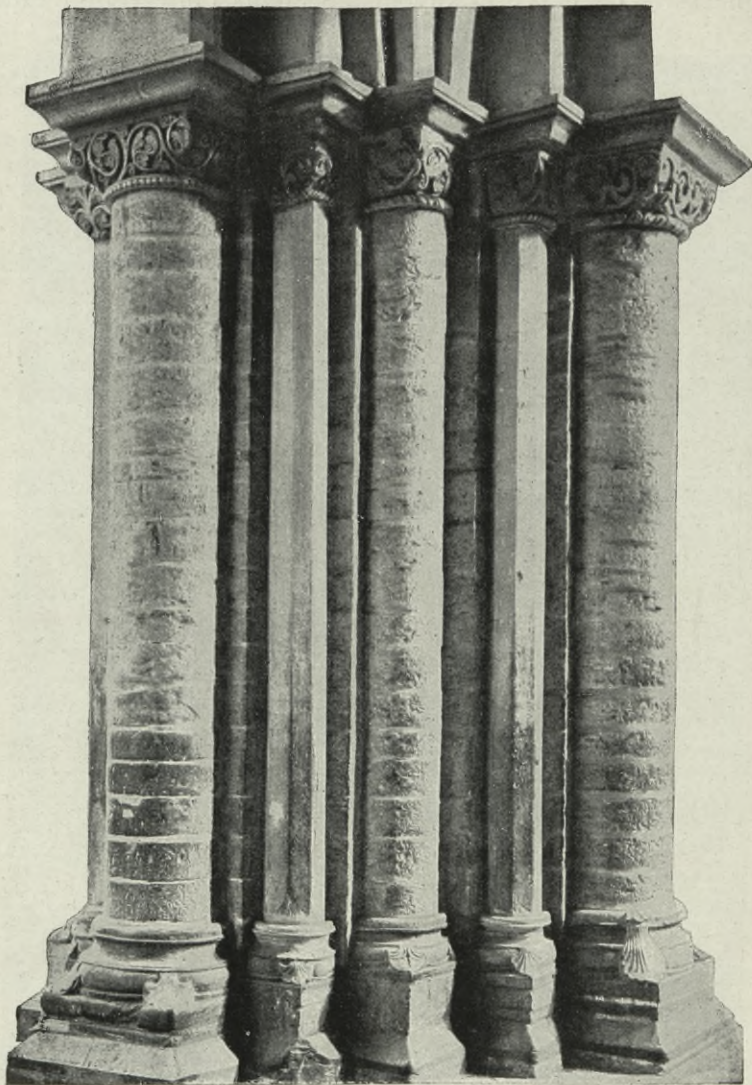
Faisceau de colonnettes à l'angle de la grande nef et du transept. Cliché de E.-J. Soil, pour « La Cathédrale de Tournai » reproduit avec l'autorisation de l'auteur.
