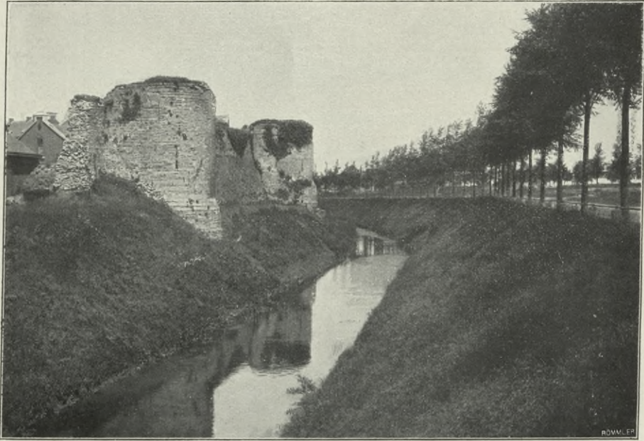
Restes de la troisième enceinte. (XIII e siècle.)
