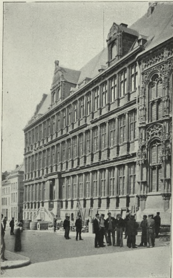
L'Hôtel de Ville. Façade renaissance.
