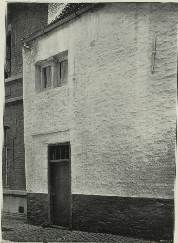
Maison romane, rue Saint-Piat, n° 18.
