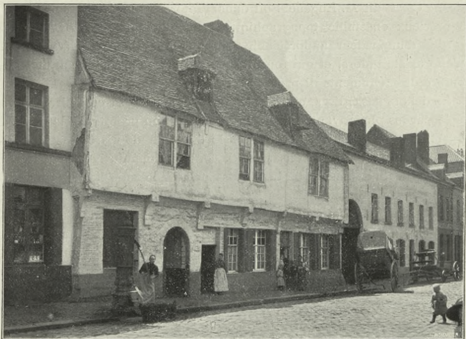
Maisons rue des Croisiers, nos 39, 41 et 43.
