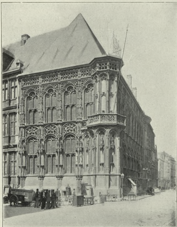
L'Hôtel de Ville. Façade et Tourelle d'angle. Partie primitive.
