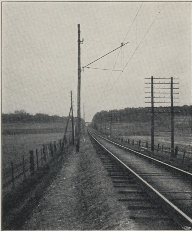
314. Upphängning medels en bärtråd med stagnering af kontaktråden.
