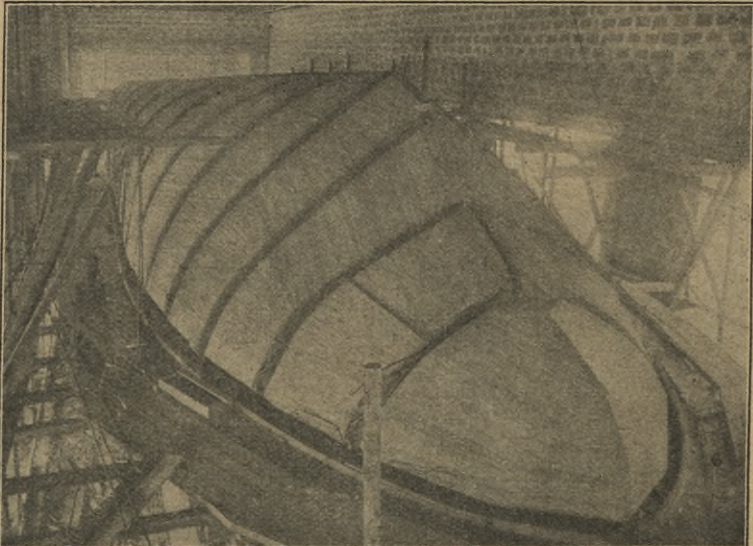
Abb. 64. Eisenbetonschiff, Bauweise Alfsen, während des Baues.
