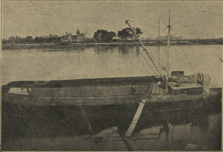
Abb. 39. Eisenbeton-Motorfrachtschiff von rd. 75 Tonnen Tragfähigkeit. Bauweise Rüdiger.
