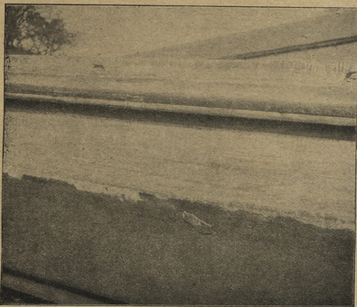
Abb. 6 zeigt ein unter Wasser ausgebessertes Loch.
