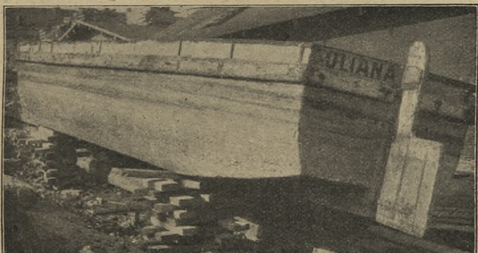
Abb. 3. Betonschute „De Juliana“ auf der Helling.
