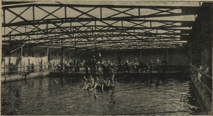
Abb. 34. Badeanstalt auf Eisenbetonpontons nach Eröffnung.
