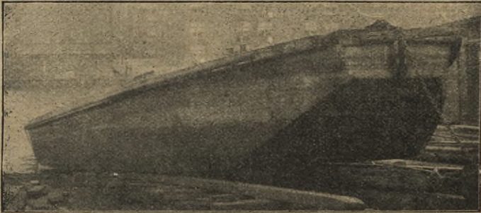
Abb. 4. Betonschute „Antoon“ auf der Helling.
