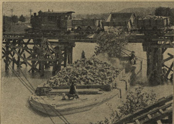
Abb. 55. Eisenbetonschute in Kanada.
