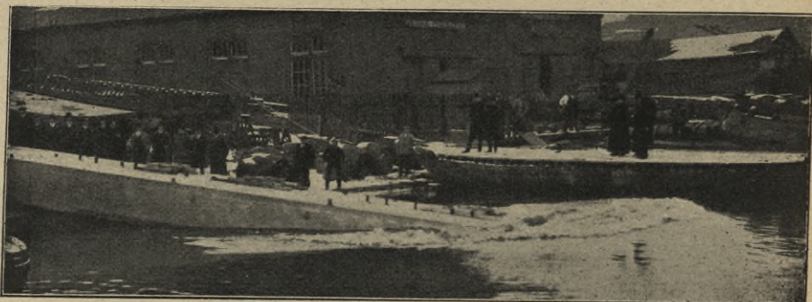
Abb. 31. Stapellauf eines Pontons von 30 m Länge, wobei die Spitze bis zu 5 m unter Wasser tauchte.
