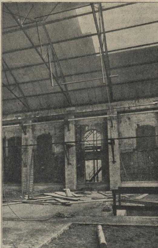
Abb. 2. Bau einer Kohlenhalle in Luzenberg bei Mannheim. Durch Bruch eines Gerüstträgers erfolgte am 27. Jan. 1912 ein Unfall.
