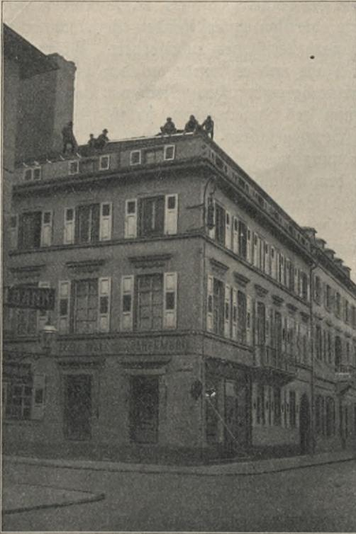
Abbildung 56. Reparaturarbeiten ohne Schutzvorkehrungen in Karlsruhe.
