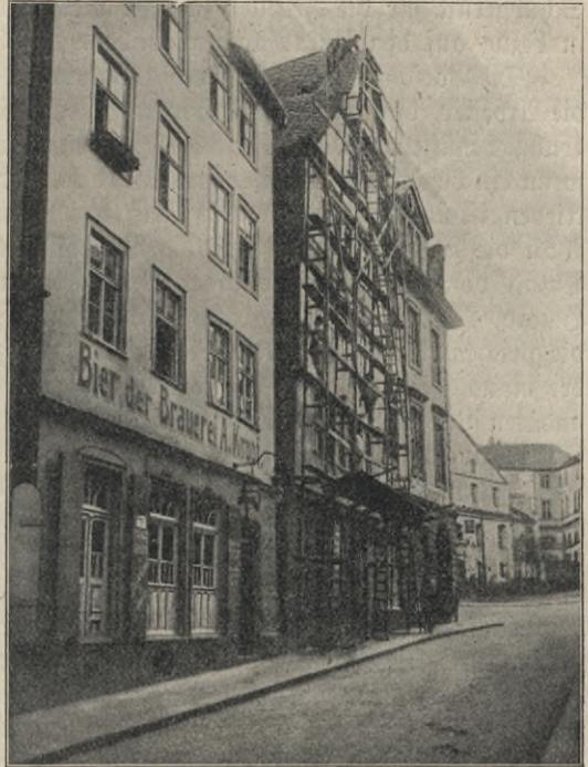
Abbildung 53. Reparaturarbeiten ohne genügende Schutzvorkehrungen in Kaffel.
