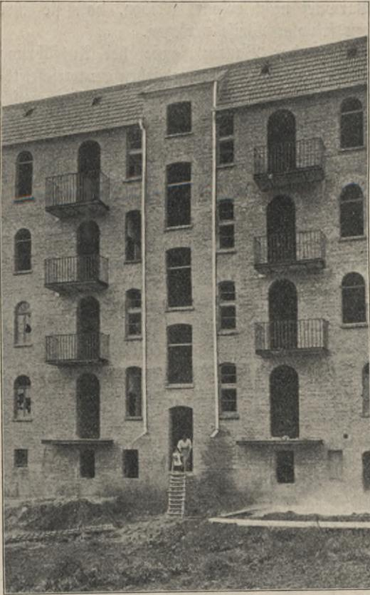
Abb. 63. Hinterfront eines Baues in Kassel, wo die Balkongeländer mit den primitivsten Hilfsmitteln montiert wurden.
