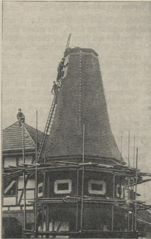
Abb. 39. Arbeiten ohne Gerüst an einem Turm in Rathenow.
