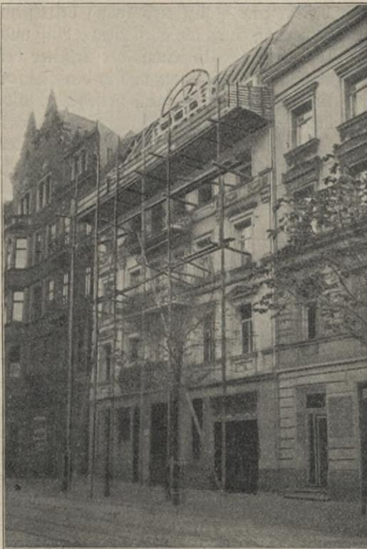
Abbildung 54. Gute Rüstung bei einem Dachumbau in Kaffel.
