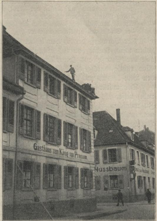
Abbildung 57. Reparaturarbeiten ohne Schutzvorrichtungen
