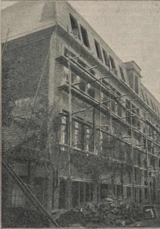
Abbildung 50. Anbringung von Dachrinnen ohne Gerüst und ohne sonstige Schutzvorkehrungen an einem Neubau in Kassel. (Siehe Seite 128.)
