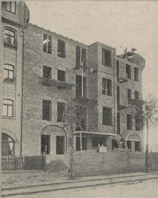
Abbildung 55. Ungenügende Fanggerüste an einem Neubau in Kassel.
