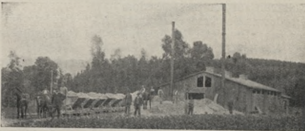
Abb. 10 Darr- bzw. Trockenanlage des Kalkdüngewerks Kruglanken
