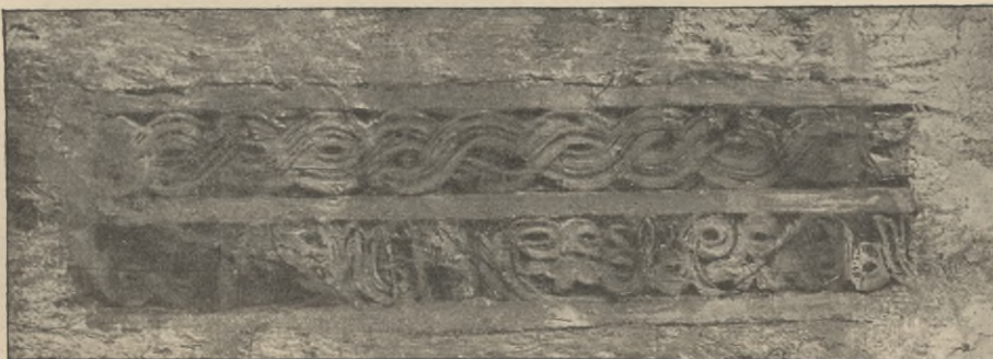
Ansicht der eingemauerten Felsplatten neben der Eingangsthüre auf der Südseite des ehemaligen Conventsgebäudes „3“.
