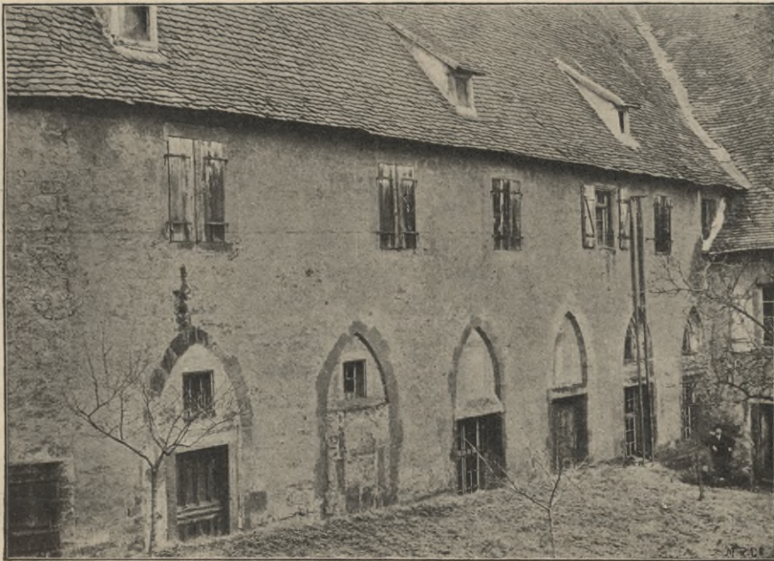
Photographische Ansicht von der Westseite des ehemaligen Kreuzganges „4“.
