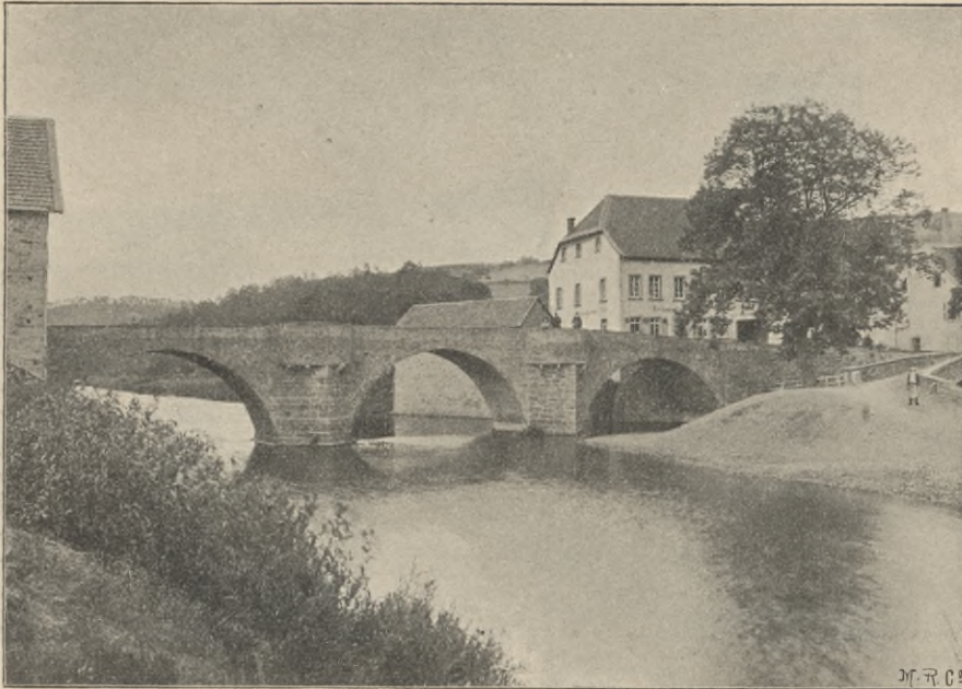
Photographische Ansicht der Brücke über den Glan in Lauterecken gegen Südwesten.
