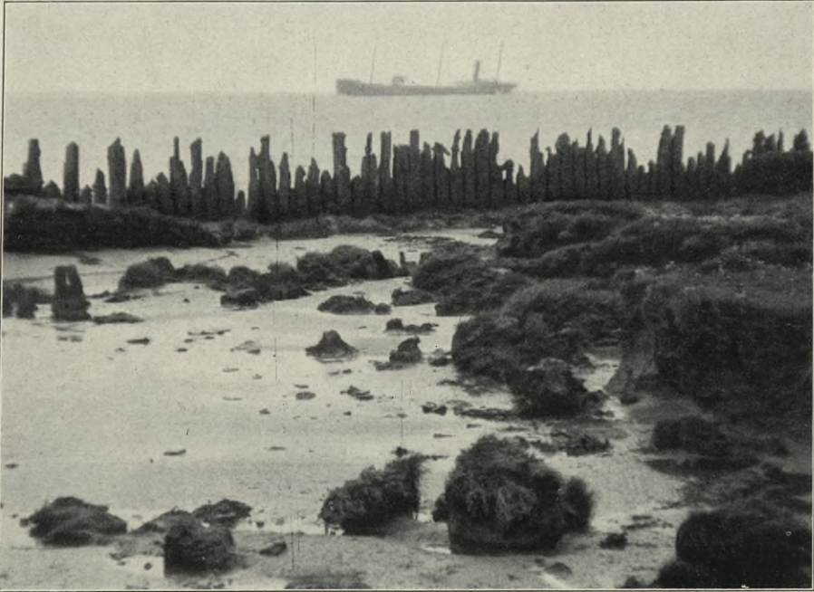
Abb. 104. Abbrechendes Ufer bei Altenbruch.
