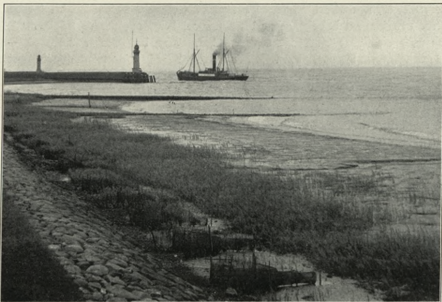
Abb. 95. Uferbefestigung, Bühnenbauten zum Schlickfang, vorn Fischbühnen, im Hintergrund Einfahrt in den Nordostkanal.
