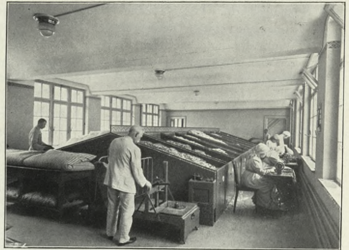
Federnlager (rechts und links Zugänge zu den elektrischen Federnreinigungsmaschinen).
