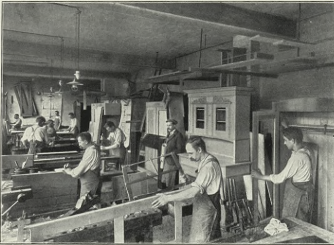
Möbelanfertigung Teil der Tischlerwerkstätten, Friedrichstraße.
