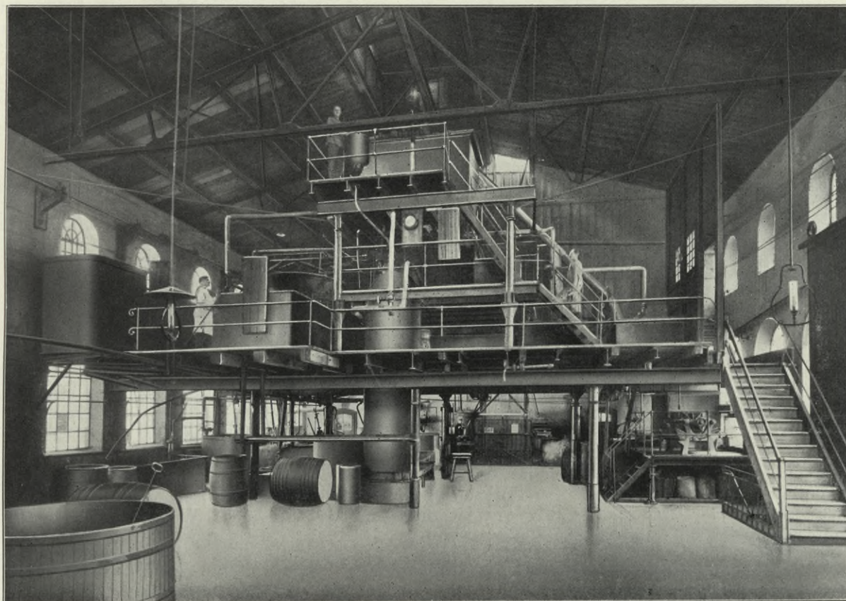
Autoklaven- und Twitchell-Fettspaltung (Glyzeringewinnungs-Anlage).
