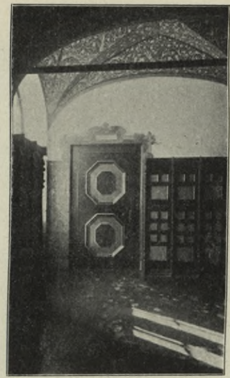
Abb. 43. Hauptgebäude. Einflügelige Tür im I. Obergeschoß.
