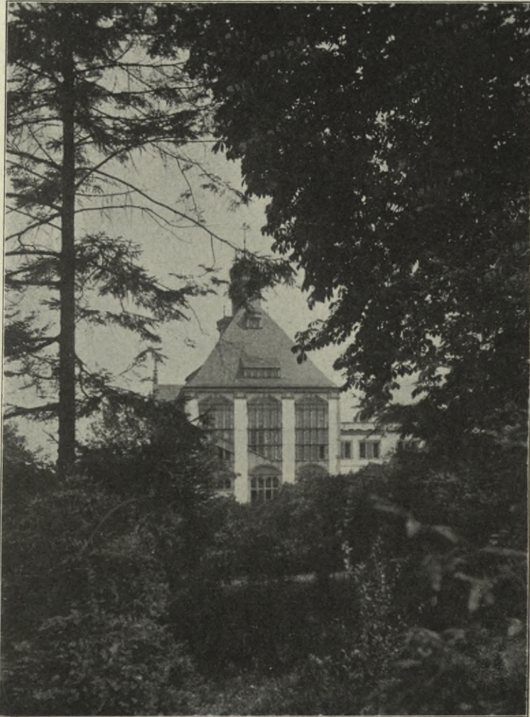
Abb. 32. Hauptgebäude. Hörsaal vom Prinzengarten gesehen.
