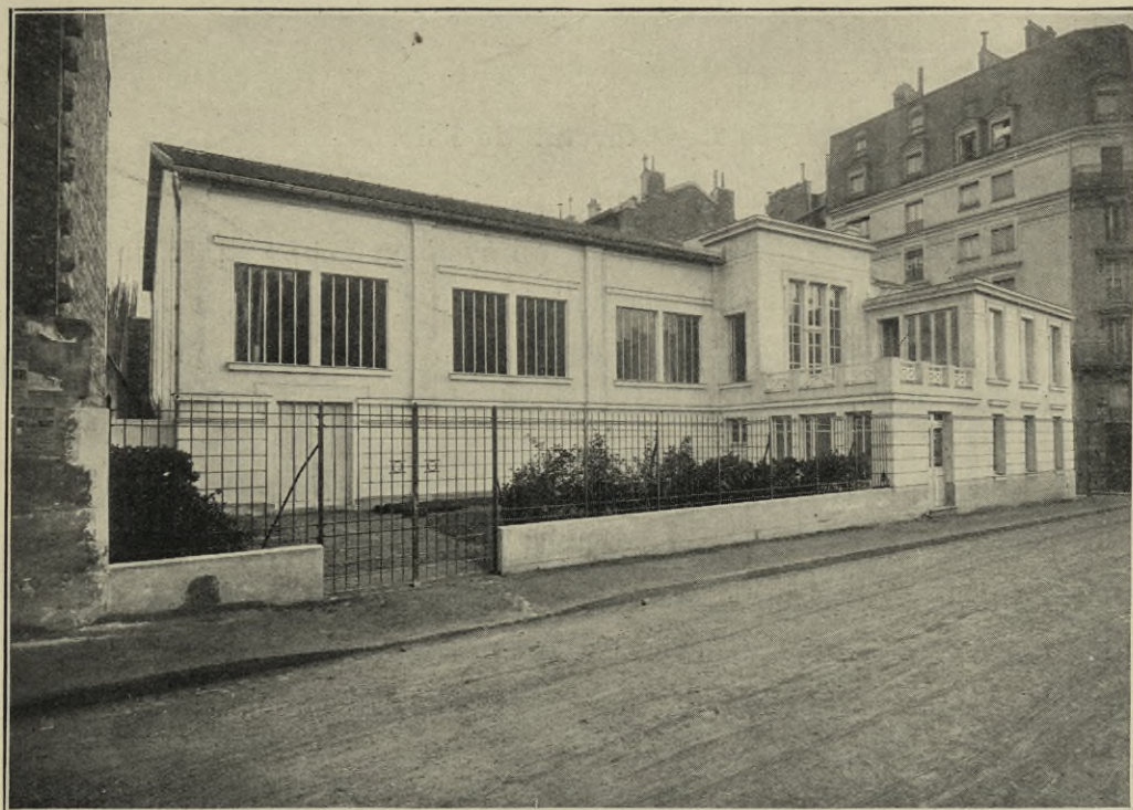
FIG. 4. — Vue extérieure sur la rue Boileau.
