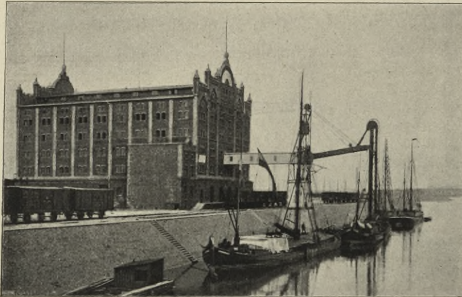
Elektrisch betriebener Elevator der Düsseldorfer Lagerhaus-Gesellschaft.
