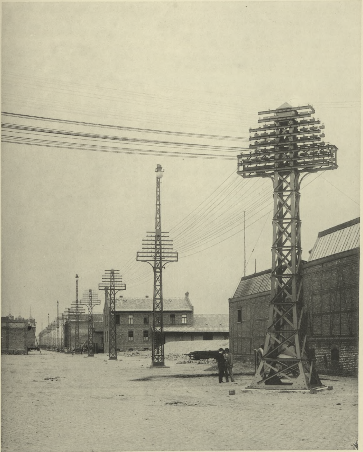
Licht- und Kraftleitungsführung über die Kaistraße.
