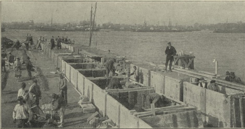
Anfertigung von Betonblöcken für den Aufbau dieser Kaimauer.
