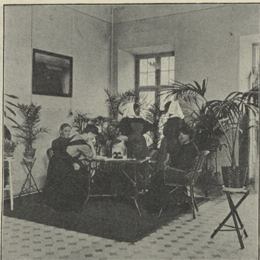
Abb. 5. Aufenthaltsraum im Erdgeschoß des Hauptbaues.
