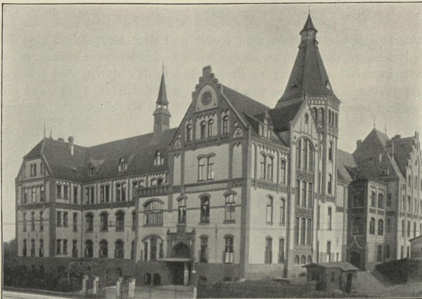
Ansicht des Krankenhauses von der Straßenseite.
