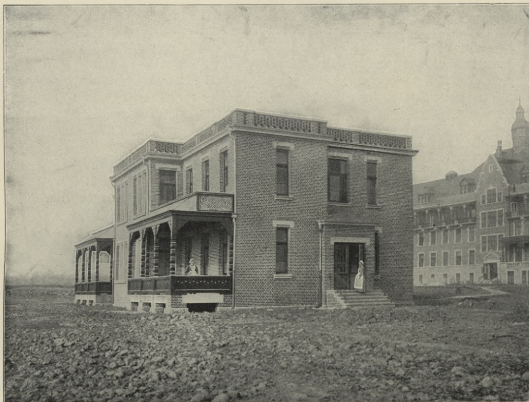
Ansicht des Infektionshauses von Süden.
