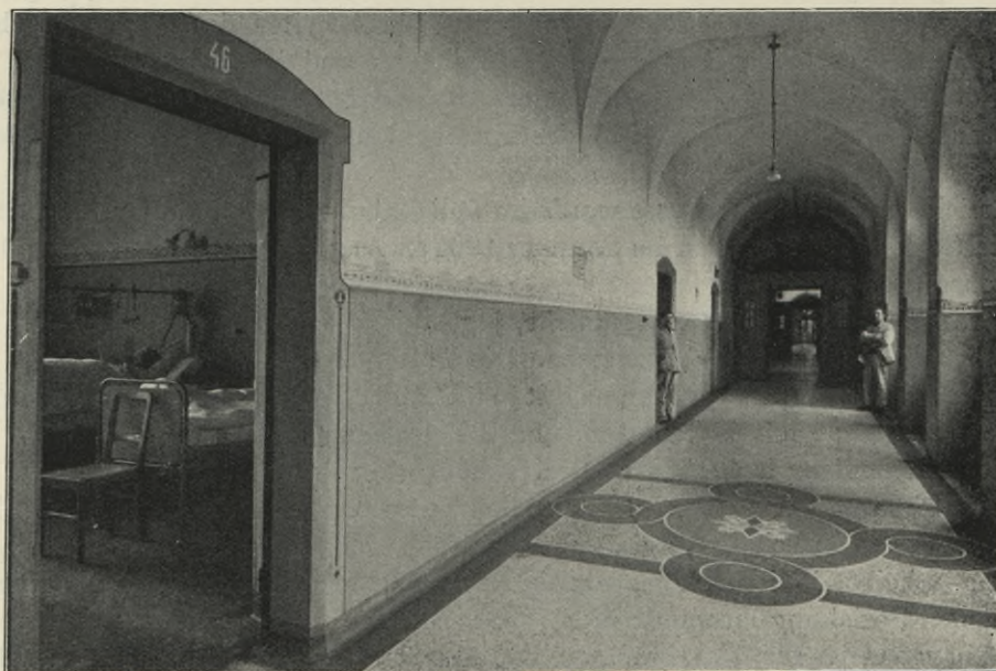
Korridoransicht mit geöffneten Krankenzimmern.
