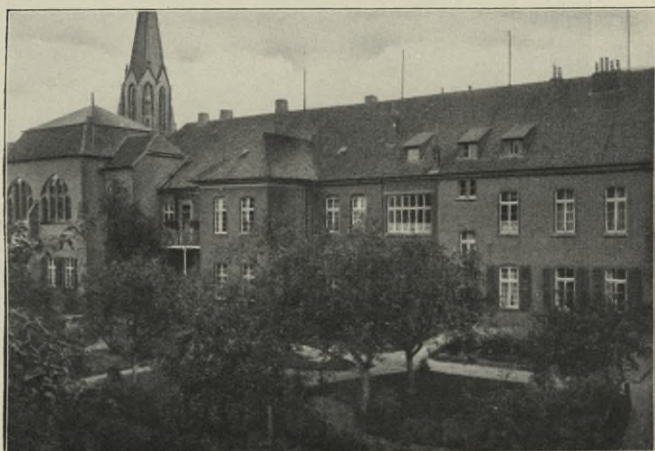
Rückansicht des Krankenhauses.
