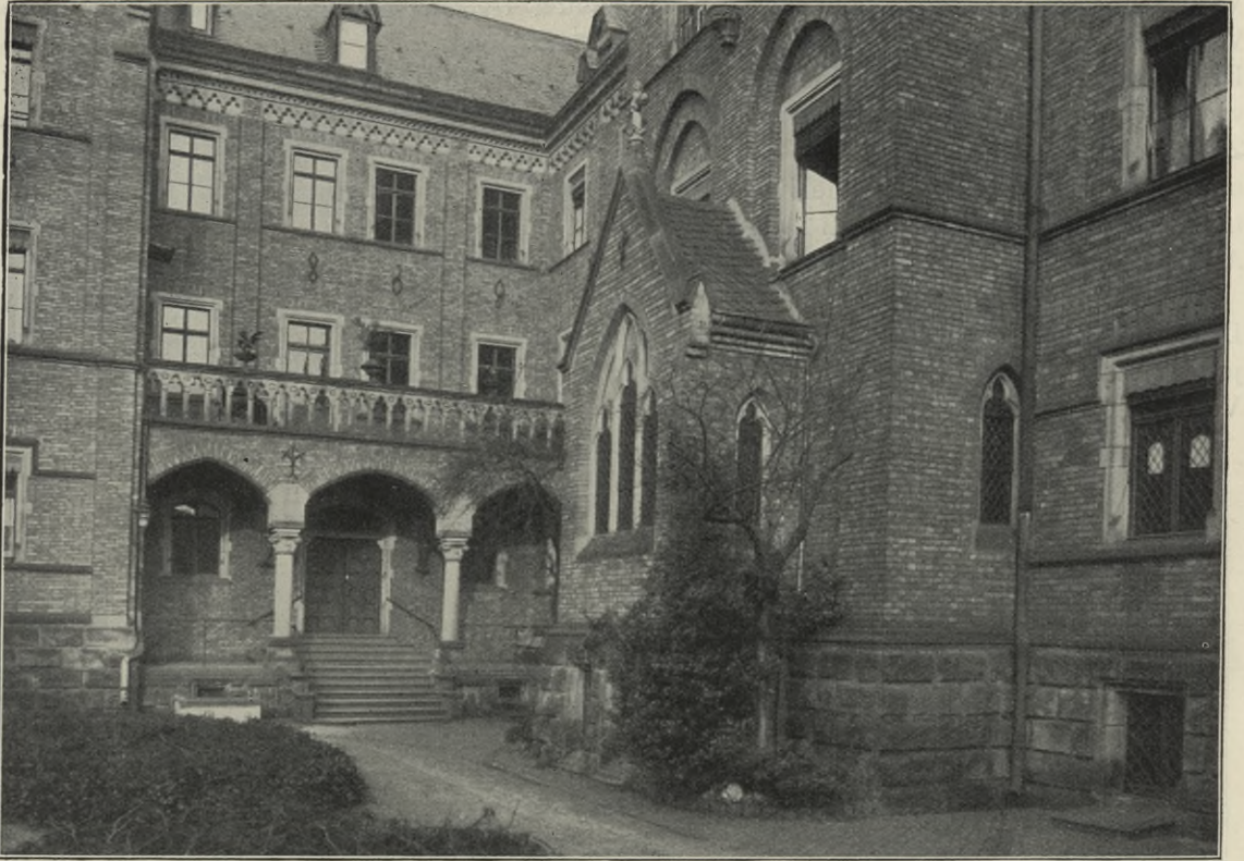
Alter Haupteingang und Terrasse.
