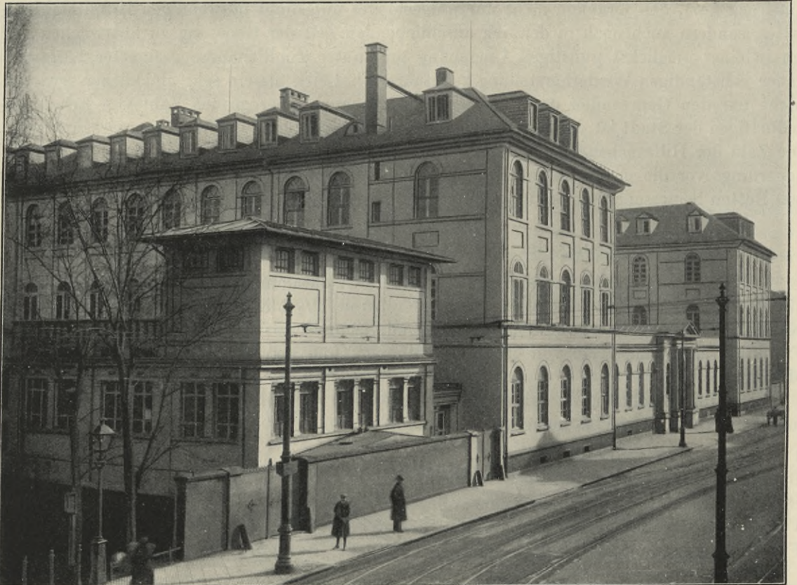
Ansicht des Hospitals von der Straße aus.
