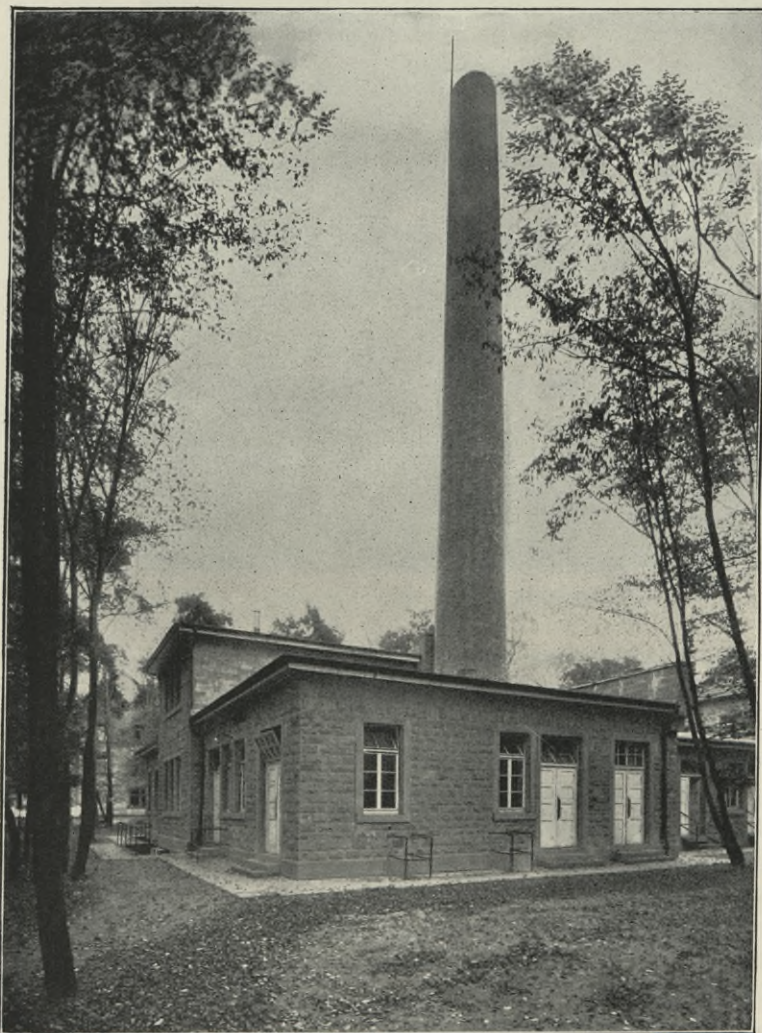
Fig. 3. Kesselhaus und Waschküche.
