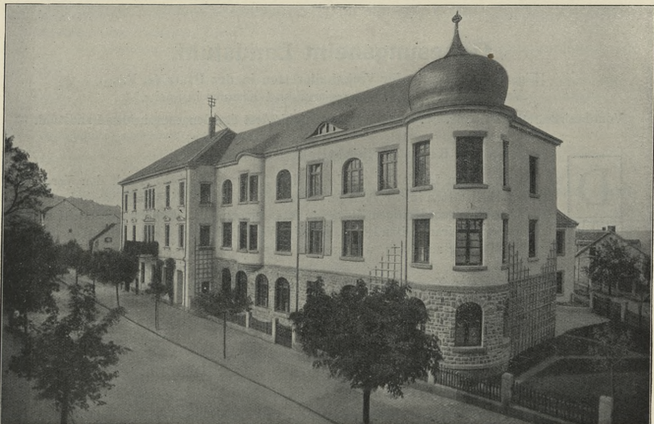
Genesungsheim Landstuhl: Hauptfassade.
