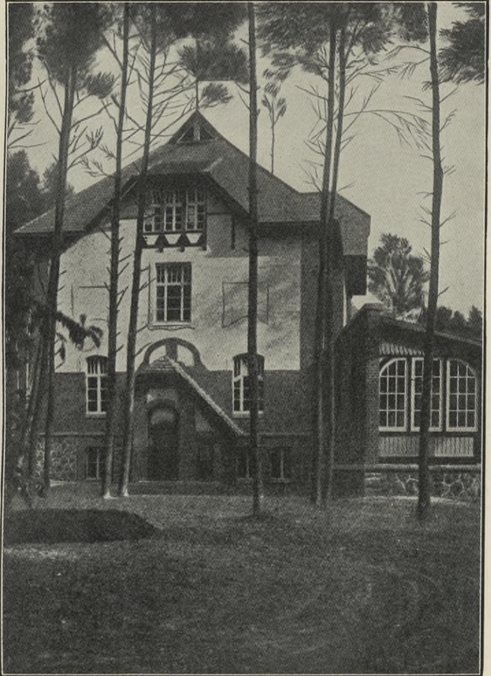
Westseite des Heims.
