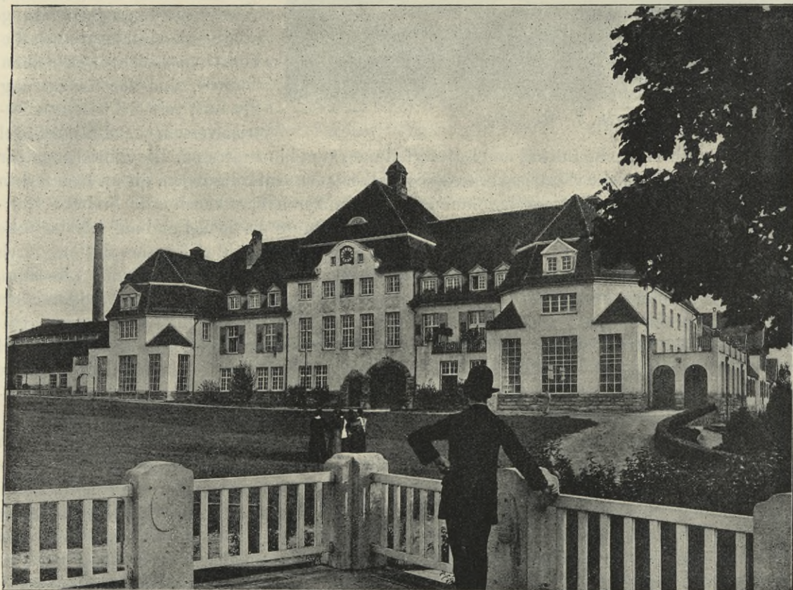
Abb. 6. Wirtschaftsgebäude mit Kesselhaus.
