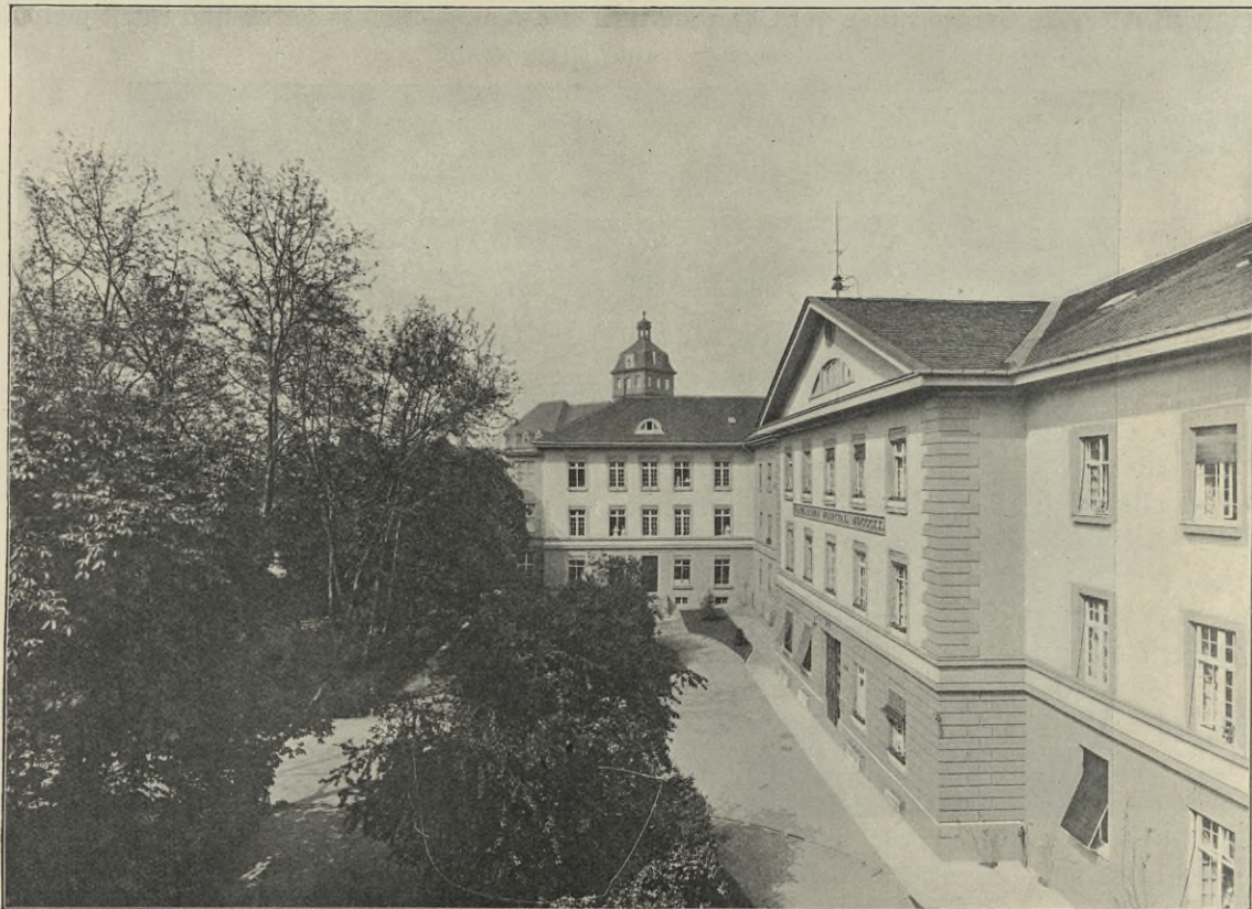
Abb. 3. Ansicht des Hauptbaues gegen Westen.
