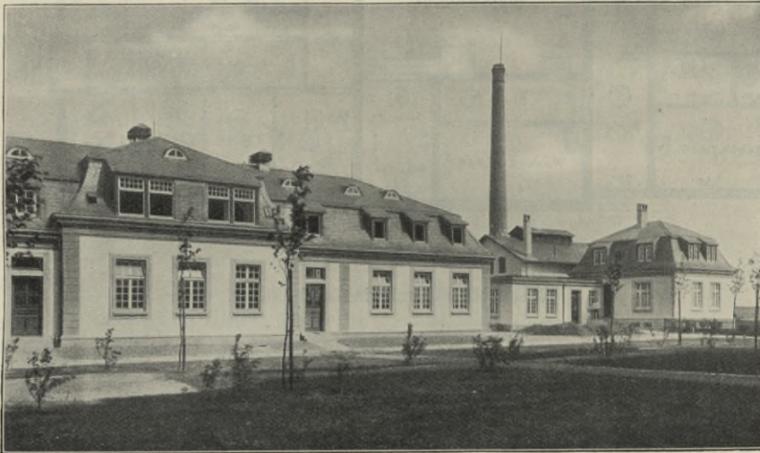
Hebammenlehranstalt Bochum: Wäschereigebäude mit Isolierabteilung. Kesselhaus mit Heizerwohnung.
