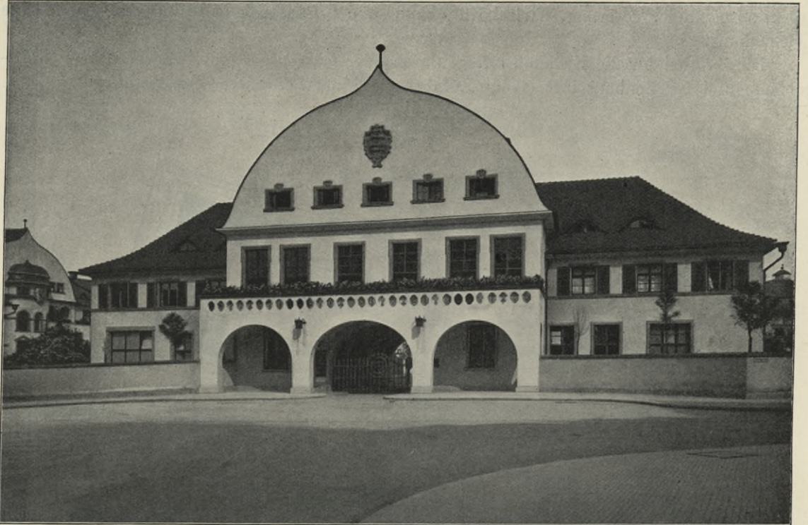
Haupteingang, Gebäude der Verwaltung und der Poliklinik.
