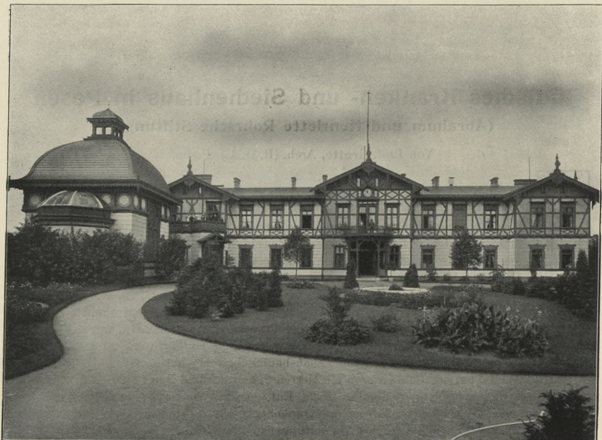
Jüdisches Kranken- und Siechenhaus in Posen.
