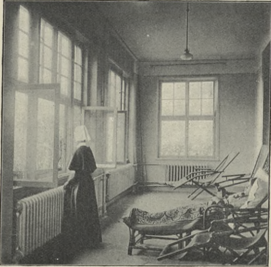
Abb. 7. Veranda im II. Stock des Hauptbaues.
