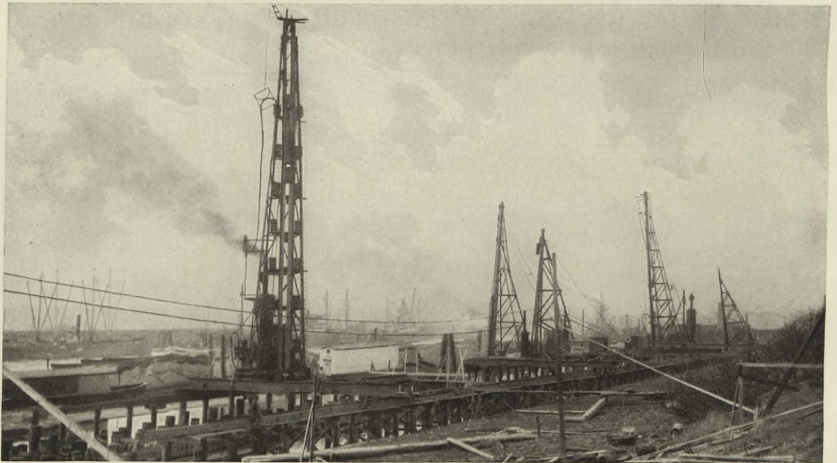
KAIMAUER IM KOHLENHAFEN VOR DER VULKANWERFT IN HAMBURG. Größte Kaimauer in Deutschland, Wassertiefe 13 m.
