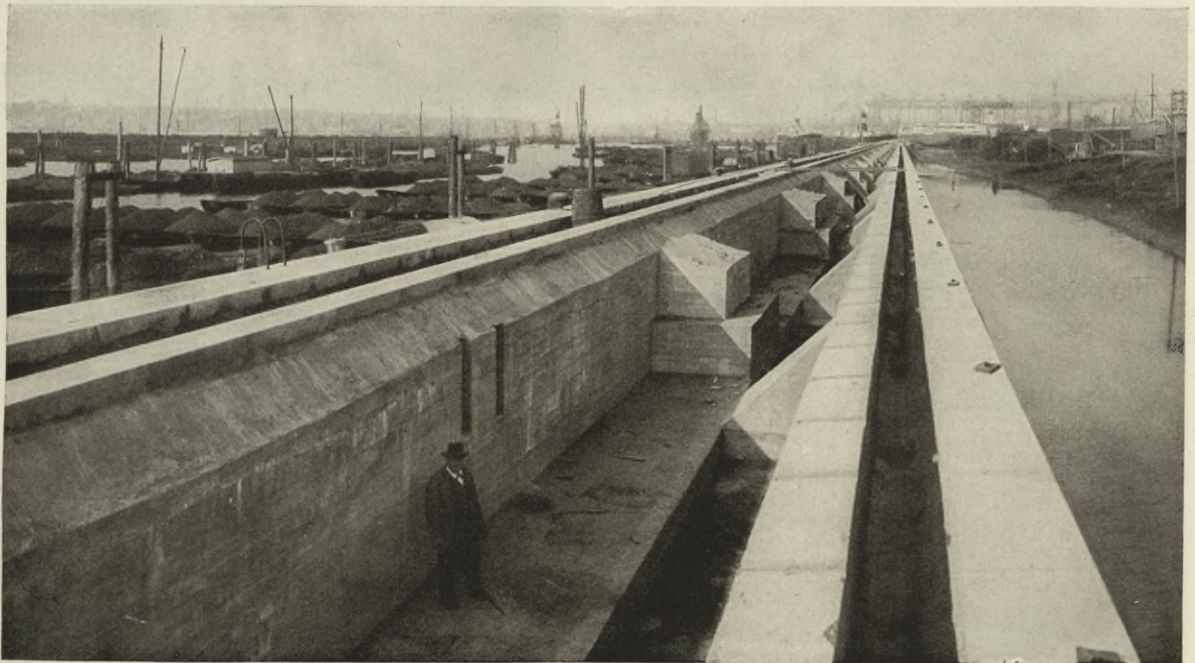
KAIMAUER IM KOHLENHAFEN VOR DER VULKANWERFT IN HAMBURG. Größte Kaimauer in Deutschland, Wassertiefe 13 m.
