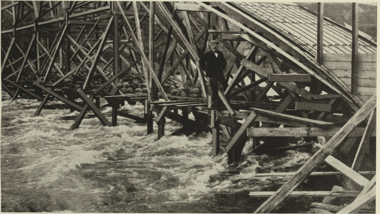
DETAIL VOM GERÜST DER FNJÓSKÁ-BRÜCKE.
